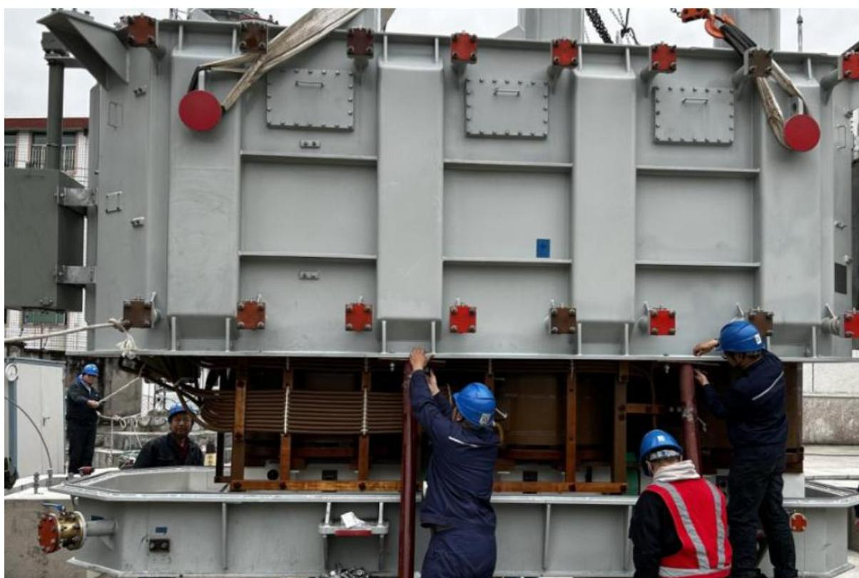
Рисунок 3 - Разберите трансформатор для проверки механического состояния катушек обмоток
