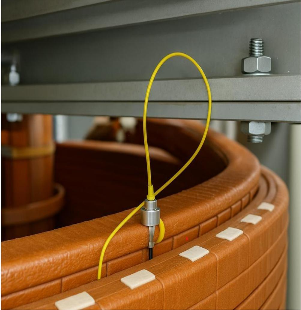
Рисунок 6 – Реальное размещение волоконно-брэгговского (FBG) датчика в зоне горячей точки обмотки трансформатора
