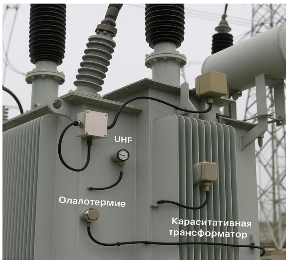
Рисунок 12 - Фактическая установка нескольких типов датчиков в главный трансформатор 330 кВ
