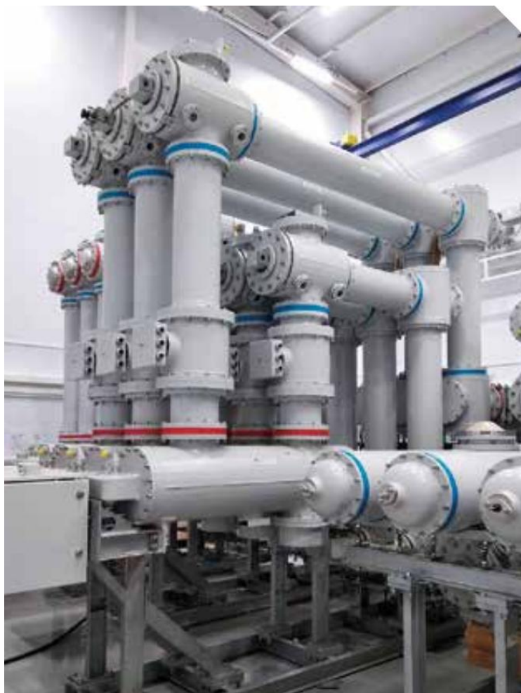
Рисунок 4.2 – Внешний вид КРУЭ серии ЯГГ-220
