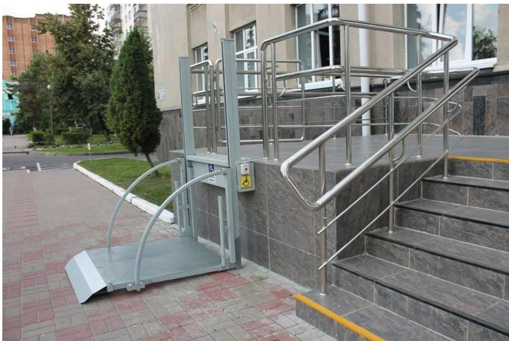
Рисунок 16 – Вертикальный подъемник
