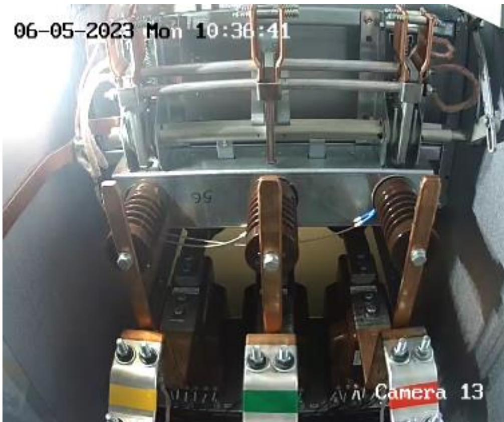
Рисунок 9 – Фотография заземляющих ножей
