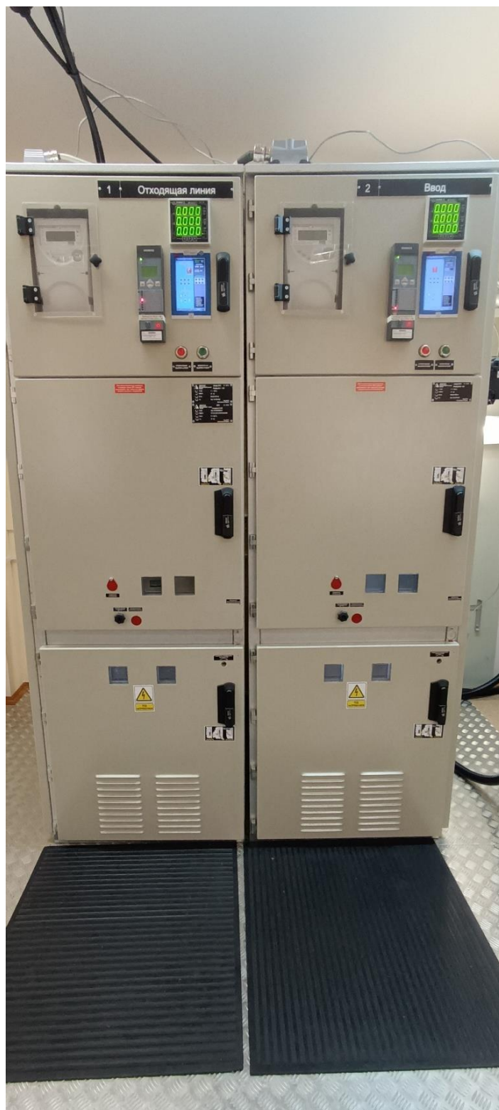
Рисунок 6 – Фотография КРУ 10 кВ
