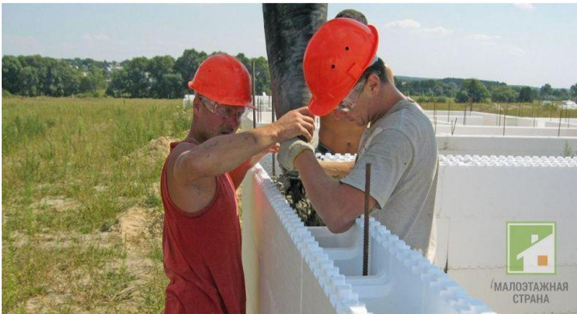
Рисунок 9 – Новейшие технологии в строительстве зданий без фундамента (несъемная опалубка)
