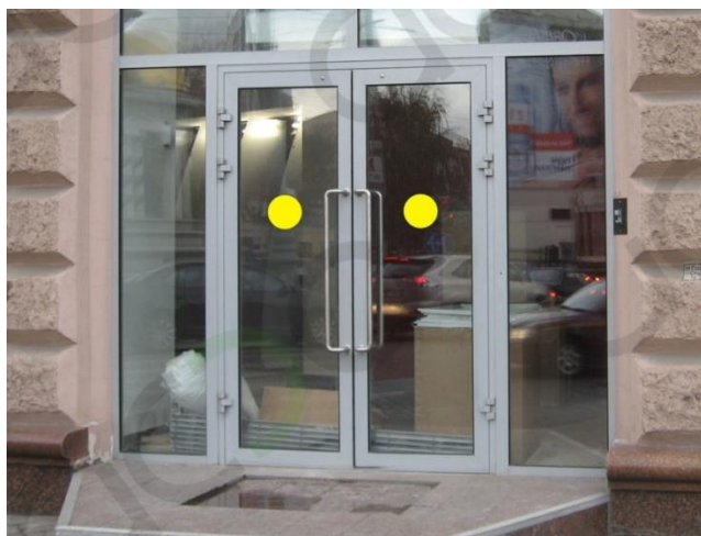
Рисунок 1 –Размещениепредупреждающей маркировки на двупольной стеклянной двери
