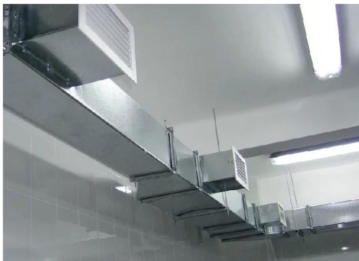
Рисунок 15 – Конструкция канальной вентиляции.
