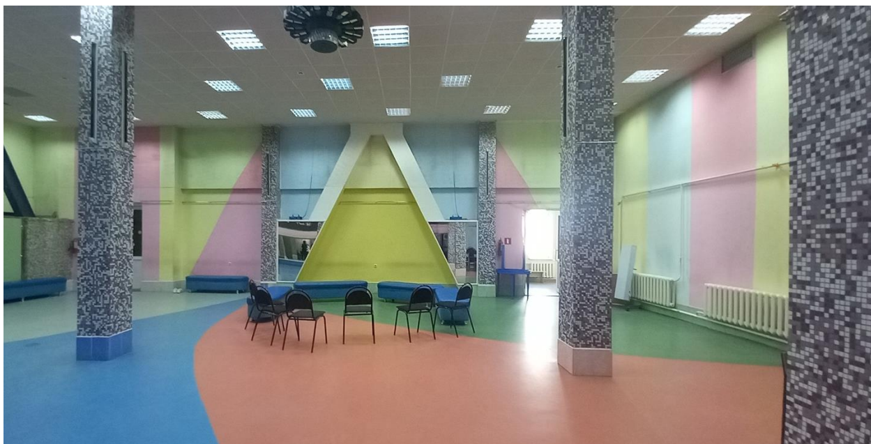
Рисунок А.3 – Состояние внутренних пространств СКЦ, диско-зал
