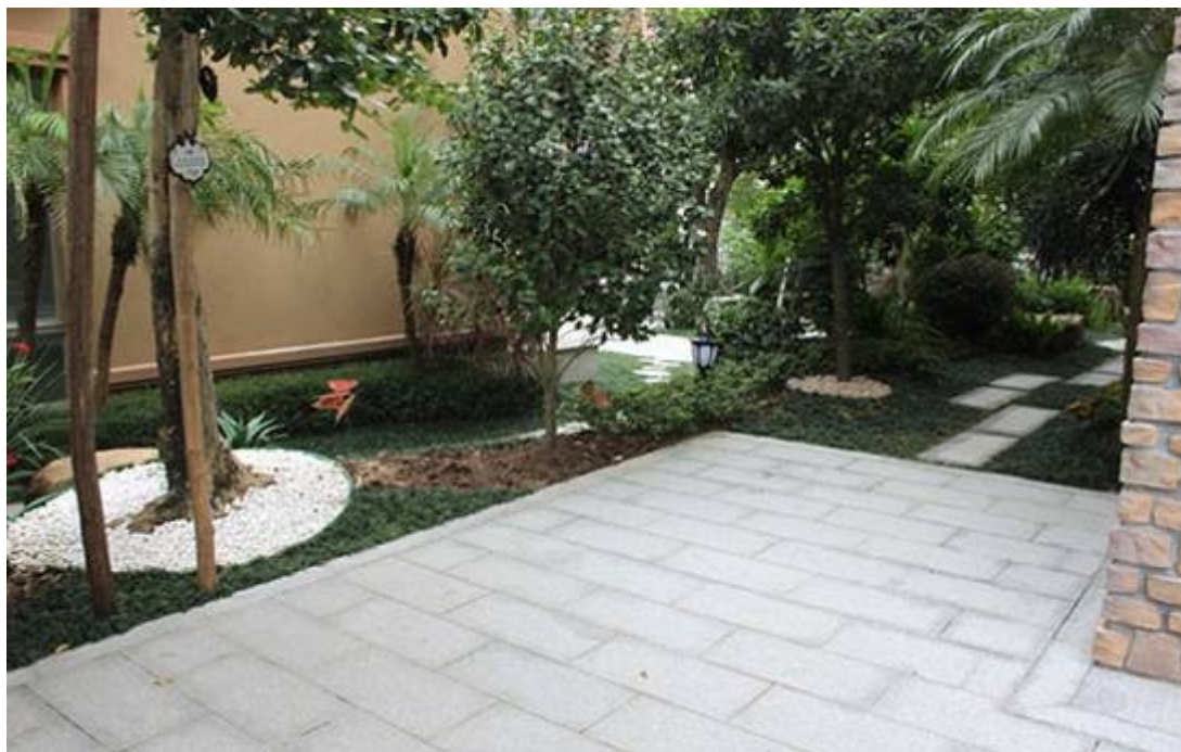
Рисунок А.22 – Фрагмент покрытия плиткой из бетона
