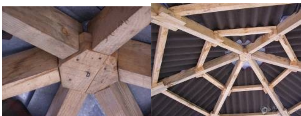
Рисунок В.4 – Соединение стропил
