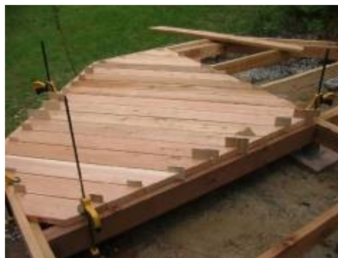
Рисунок В.3– Укладка пола
