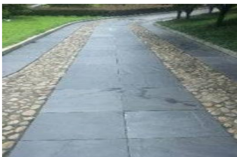
Рисунок А.22 – Фрагмент покрытия плиткой из бетона
