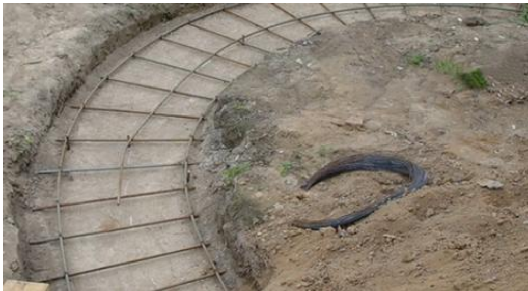
Рисунок В.55 – Фундамент мелкозаглублённый по песчаному утрамбованному основанию
