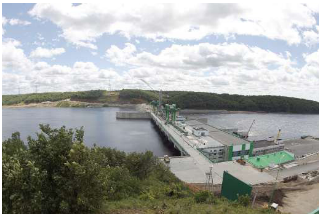
Рисунок А.4 – Нижнебурейская ГЭС
