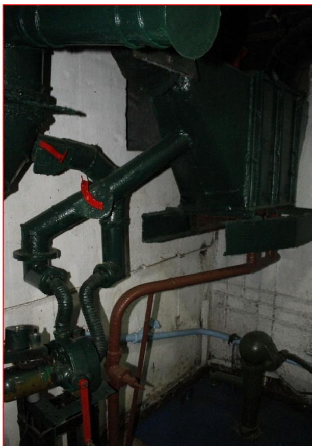
Рисунок 22 - Калорифер для подогрева приточного воздуха
