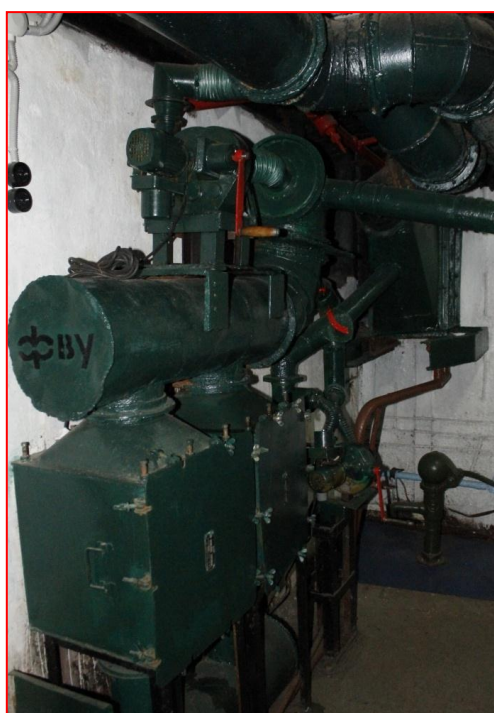
Рисунок 21 – Фильтровентиляционная установка
