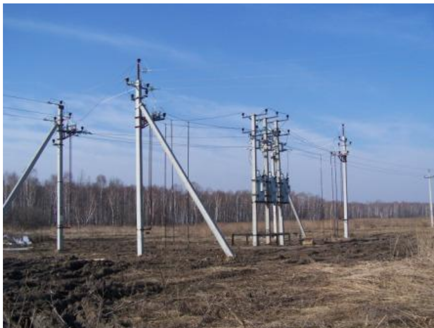
Рисунок 22 – Установка ПАРН в расщепке линии электропередач в критических точках падения напряжения
