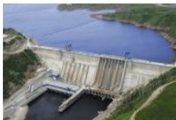
Вид на водохранилище
