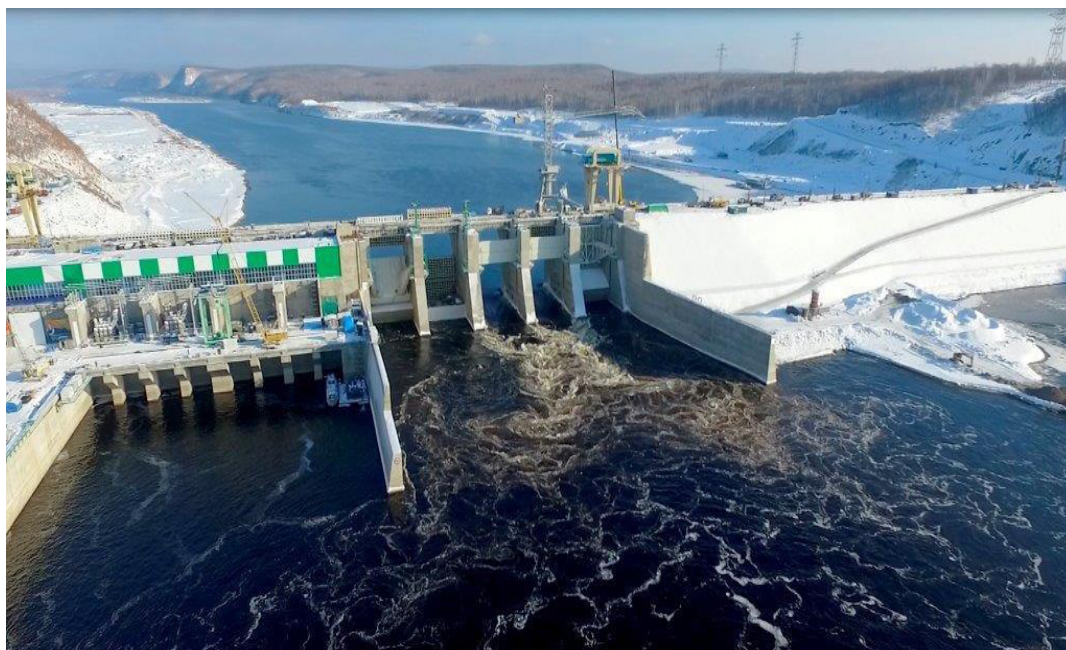
Рисунок 8 – Вид на плотину Нижне-Бурейской ГЭС
