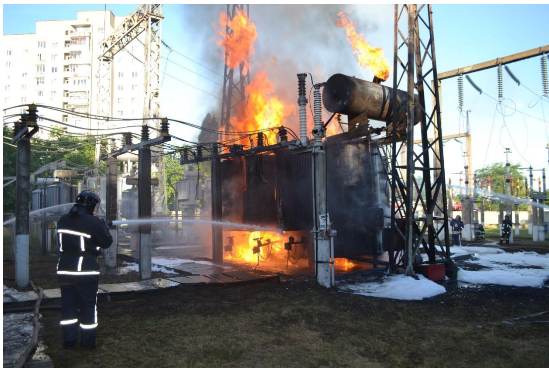
Рисунок 21 – Тушение пожара на подстанции
