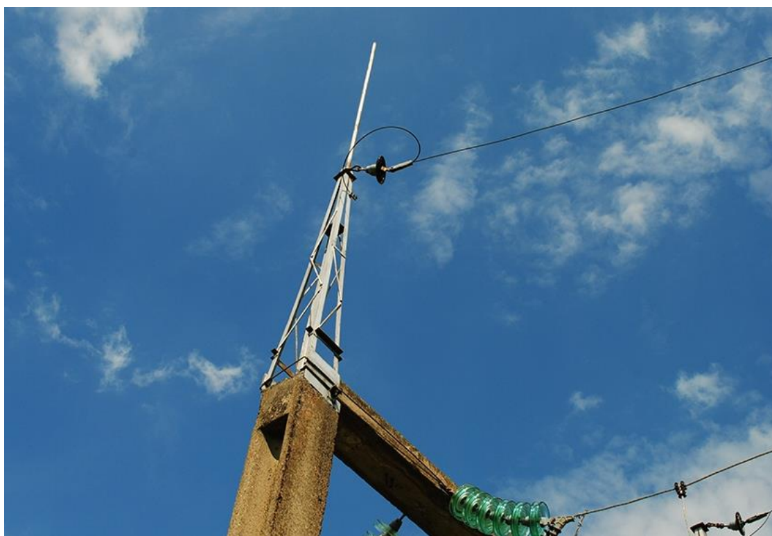
Рисунок 20 – Молниеотвод
