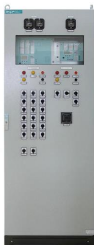
Рисунок 18 – Шкаф релейной защиты ЭКРА ШЭ2607 155
