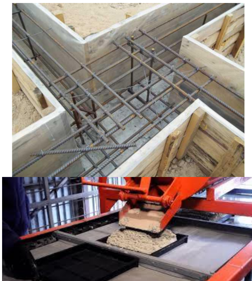
Рисунок В.11 – Армирование и вибротитье
