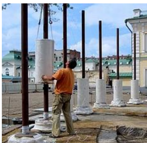
Рисунок В.7 – Монтаж и крепление колонн-опор
