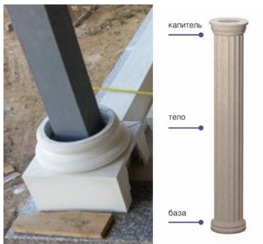
Рисунок В.6 – Монтаж опоры
