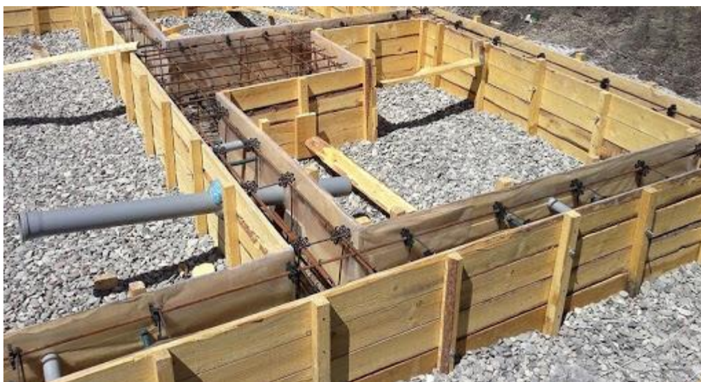
Рисунок В.3 – Опалубка
