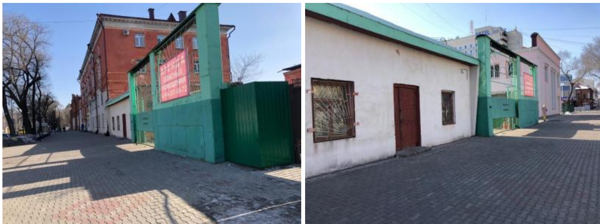
Рисунок А.4 – Фотофиксация северной не реконструируемой части
