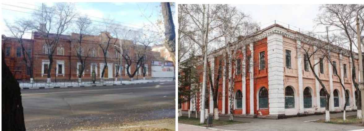
Рисунок А.2 – Здание бывшего электроаппаратного завода до реконструкции
