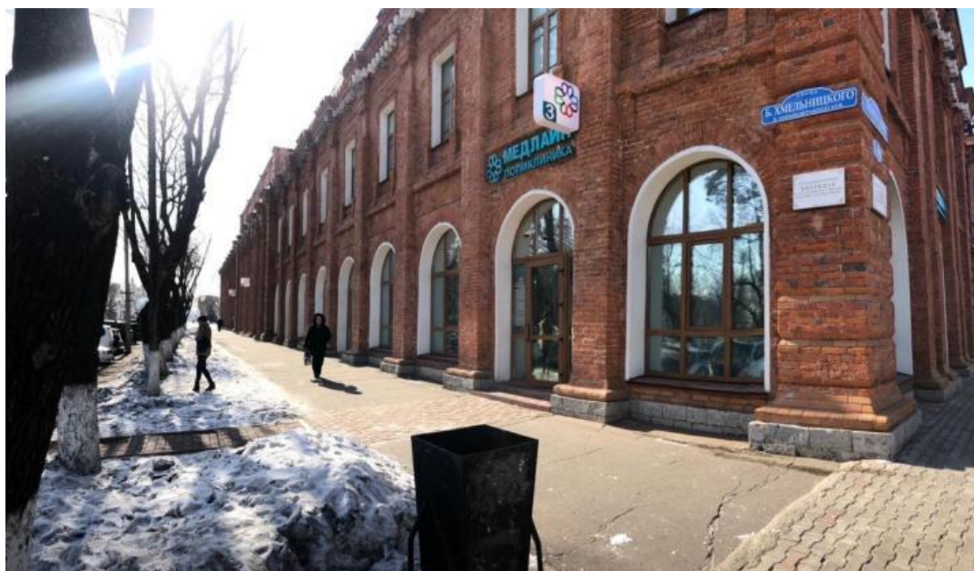
Рисунок А.3 – Северная часть, после реконструкции
