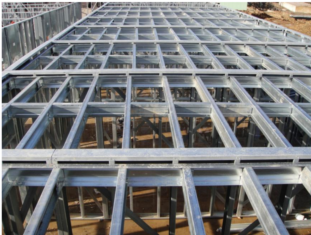
Рисунок В.5 – Лёгкие стальные тонкостенные конструкции
