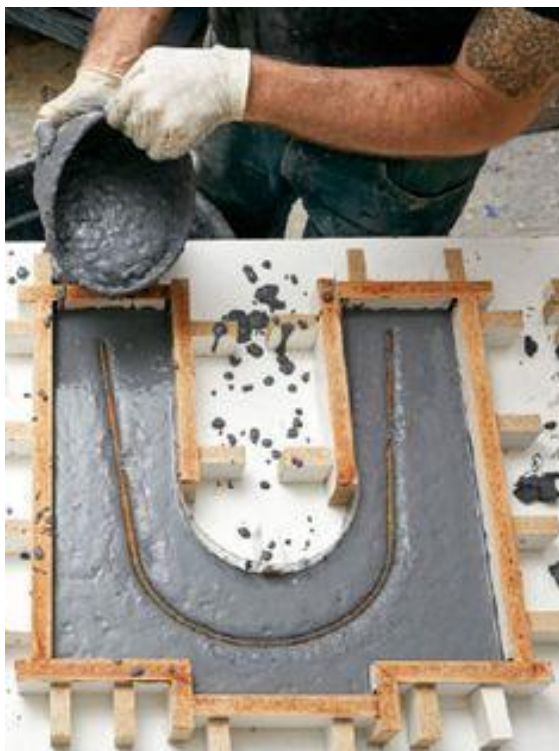
Рисунок В.6 – Заливка формы бетоном
