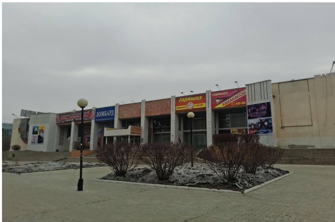
Рисунок А.2 - Фотофиксация объекта (южный фасад ДК Профсоюзов)
