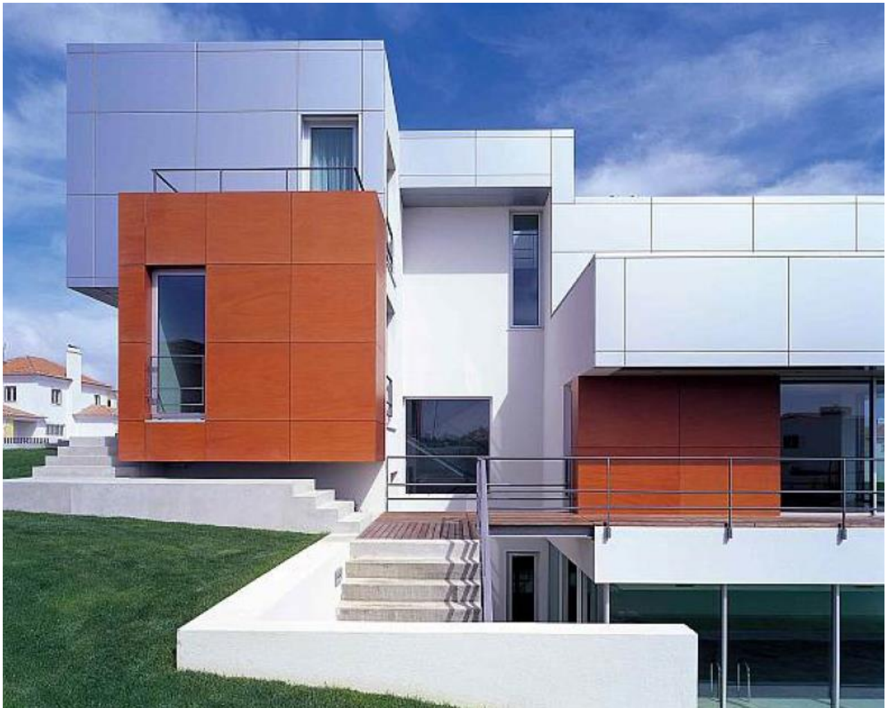
Рисунок В.2 – Пример фасада облицованного алюкобондом
