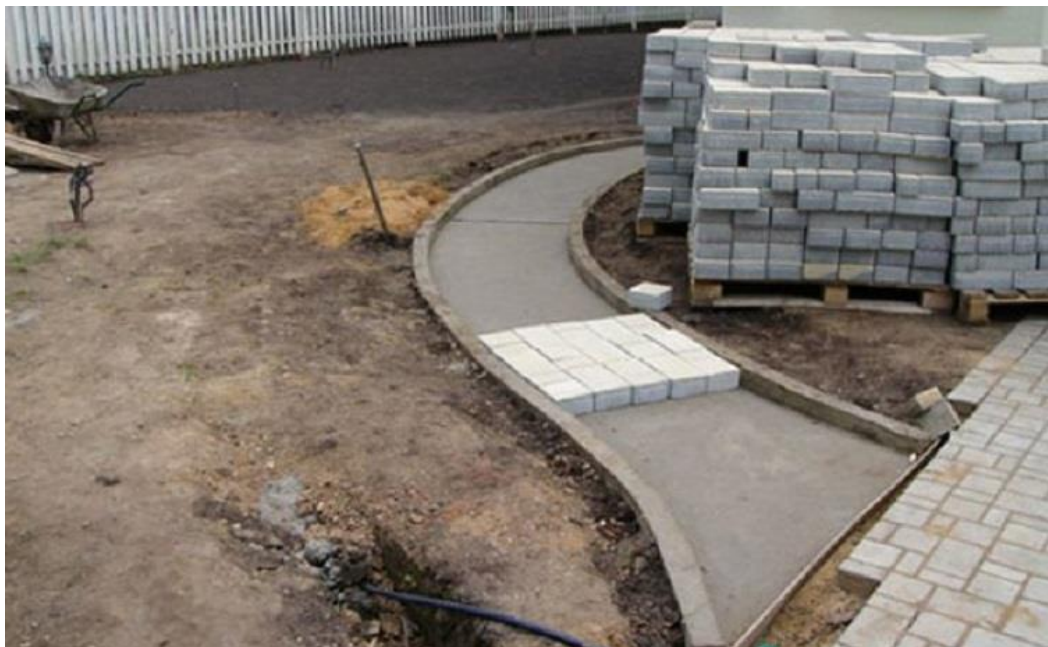
Рисунок В.2 – Установка бордюров
