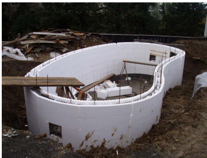
Рисунок В.9 - Несъёмная опалубка из пенополистирола
