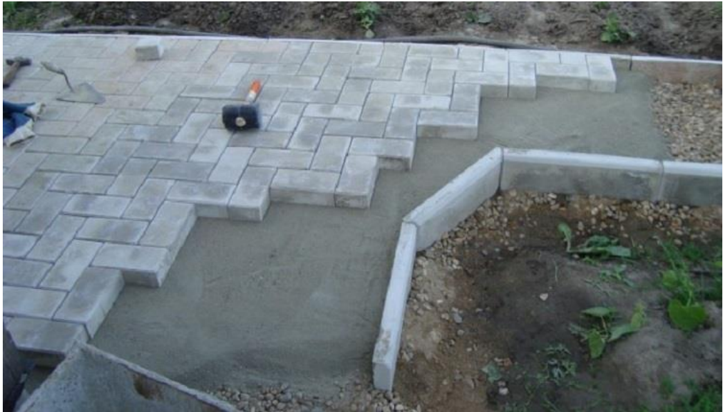
Рисунок В.1 – Процесс мощения плиткой на основе бетона
