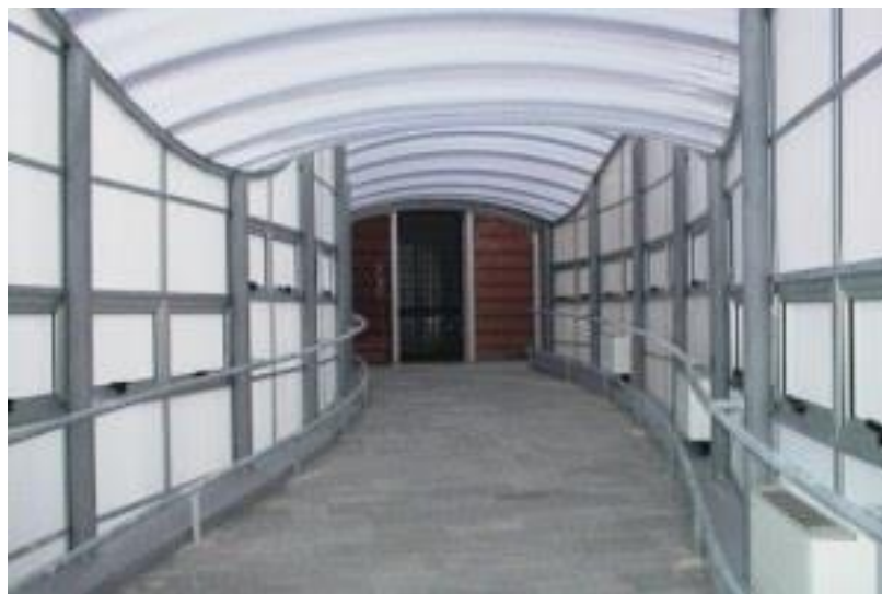
Рисунок В.15 – Применение молочного поликарбоната
