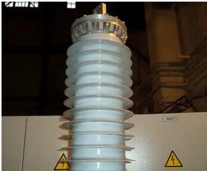
Рисунок 3.9.1 – Конструкция кабельного ввода в КРУЭ
