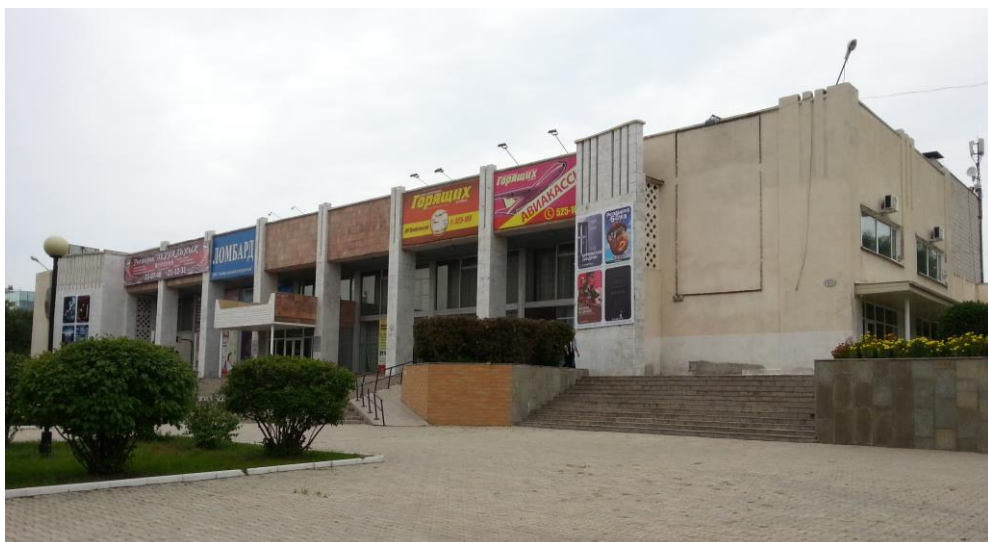
Рисунок Б.5 - Фото фиксация, существующий фасад здания
