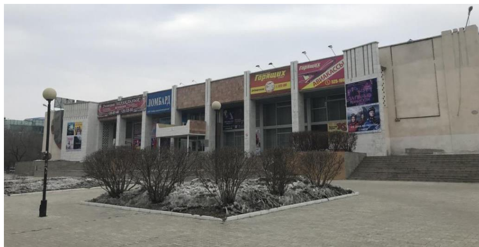
Рисунок Б.6 - Фото фиксация, существующий фасад здания
