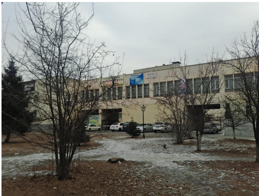
Рисунок А.4 - Фотофиксация объекта (западный фасад)
