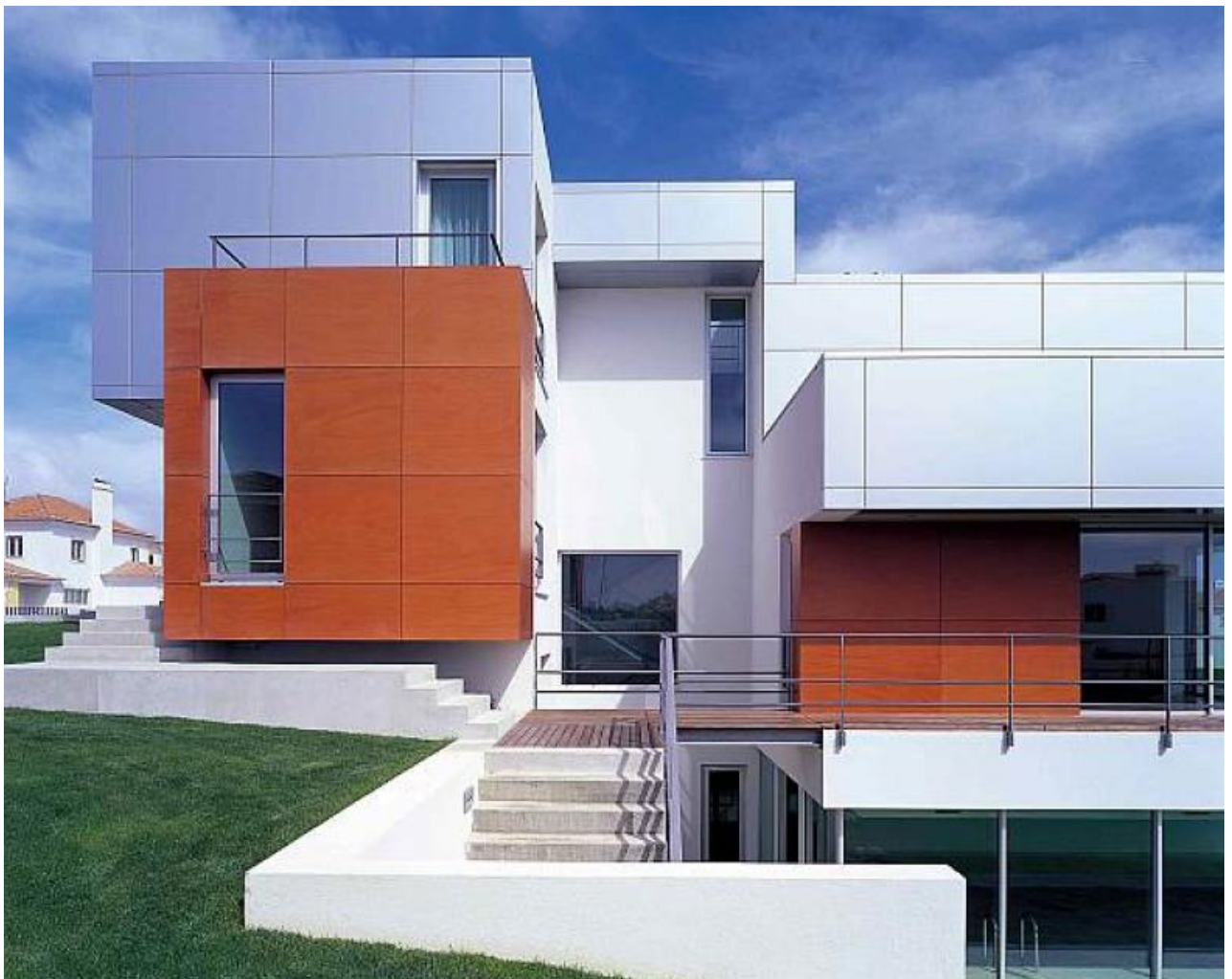
Рисунок В.2 – Пример фасада облицованного алюкобондом
