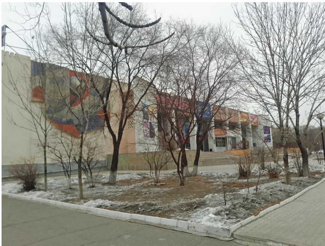
Рисунок А.3 - Фотофиксация объекта (южный фасад)
