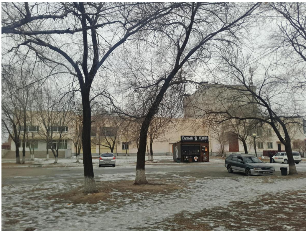
Рисунок А.7- Фотофиксация объекта
