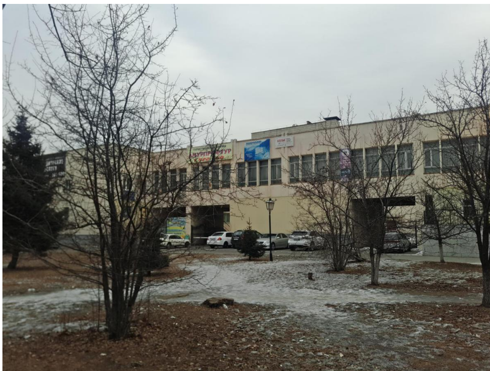
Рисунок А.10 - Фотофиксация объекта
