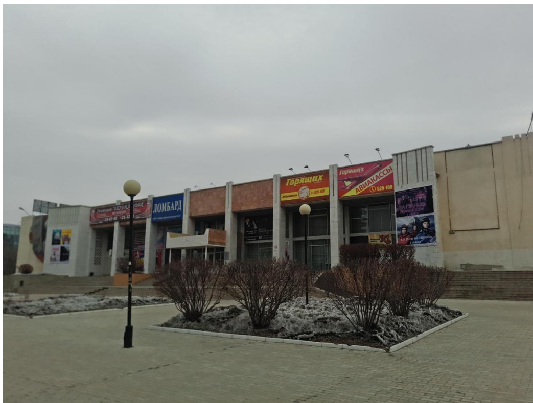
Рисунок А.8 - Фотофиксация объекта
