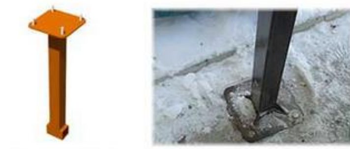
Рисунок В.6 – Крепление стоек навеса к закладным деталям
