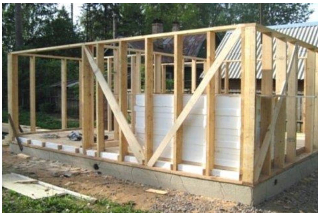
Рисунок Г.4- Соединение стоек между собой укосом
