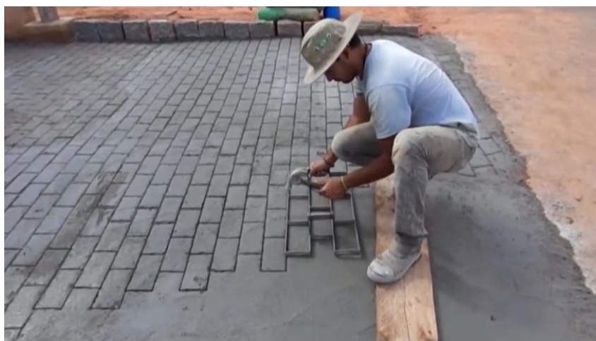
Рисунок В.8 – Создание имитации плитки
