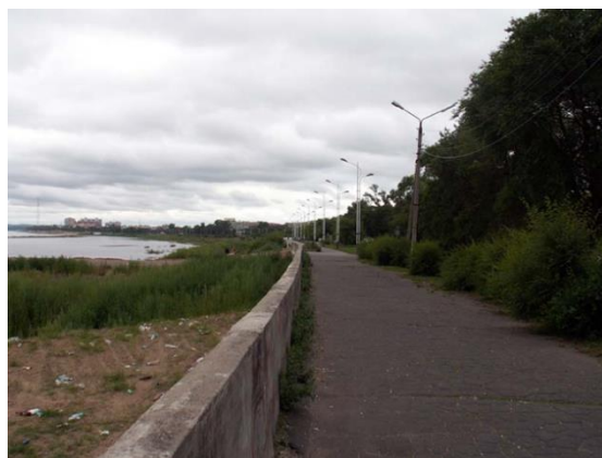
Рисунок А.1 – Набережная р.Амур до реконструкции
