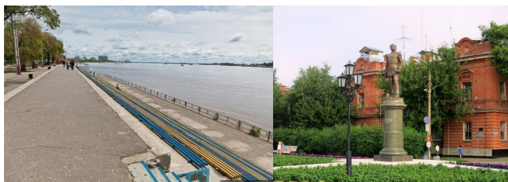
Рисунок А.3 – Набережная р.Амур до реконструкции
