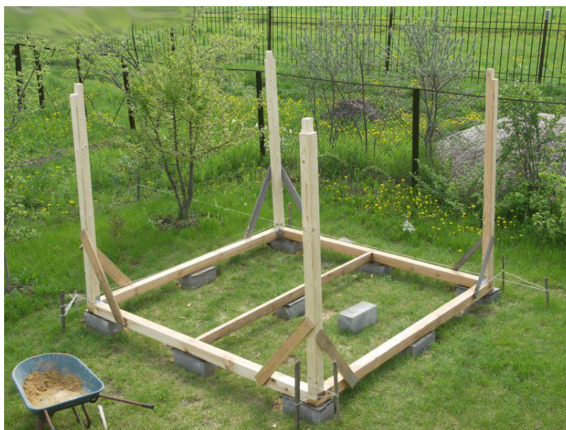
Рисунок В.2 – Строительство каркаса деревянной беседки
