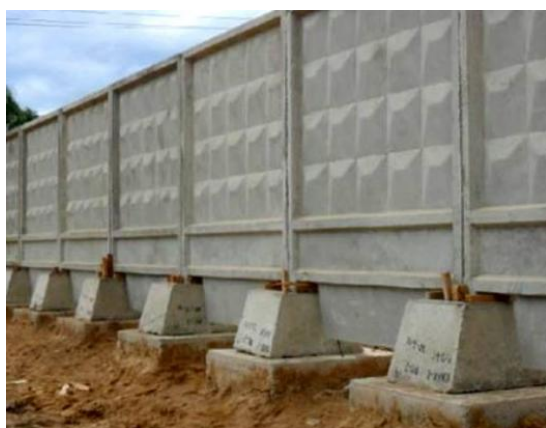
Рисунок Д.2 – Установка панелей стены, без заглабления
