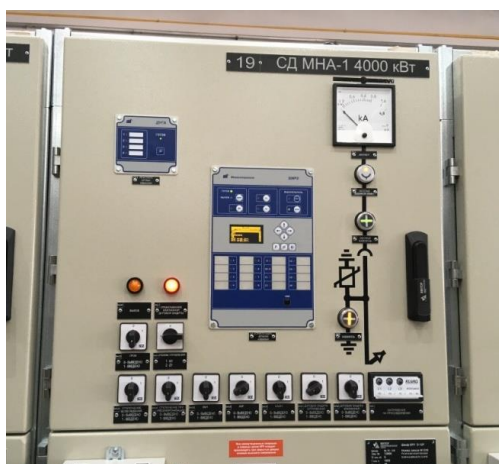
Рисунок 1.7 – Отсек вспомогательных цепей [3]
