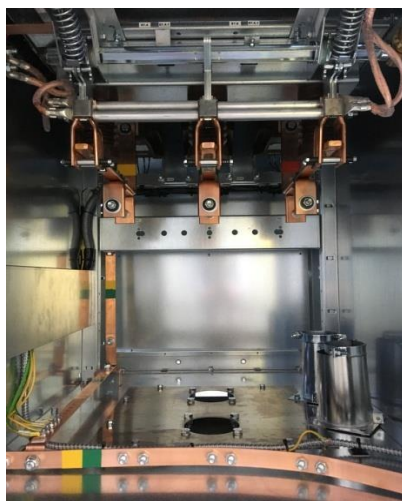
Рисунок 1.6 – Отсек присоединений [3]
