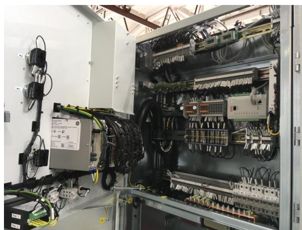
Рисунок 1.7 – Отсек вспомогательных цепей [3]
