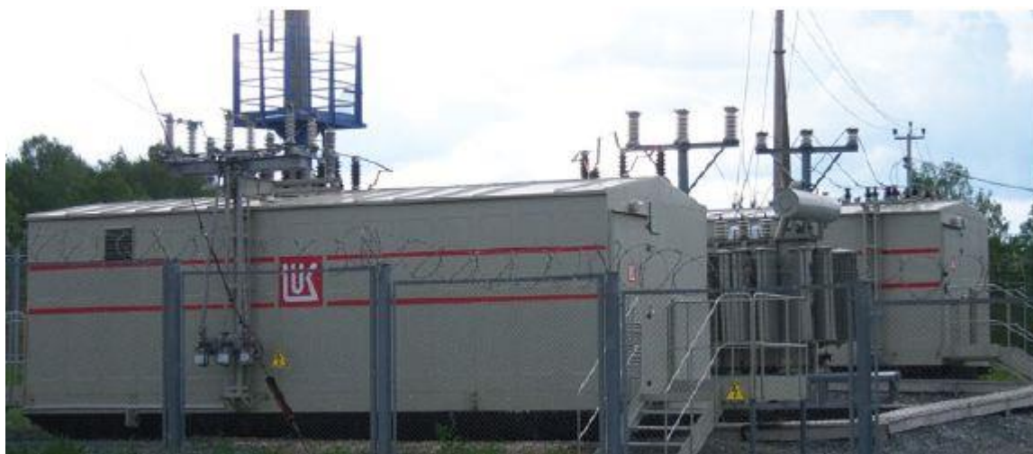
Рисунок 1.9 – Комплектная трансформаторная подстанция модульная (KTPM) серии SKP [4]
