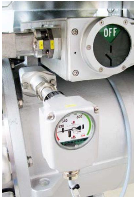
Рисунок 3.8 – Термокомпенсированный монитор плотности (давления) со шкалой [8]
