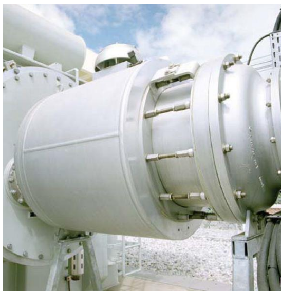
Рисунок 3.7 – Прямое присоединение трехфазного трансформатора [8]
