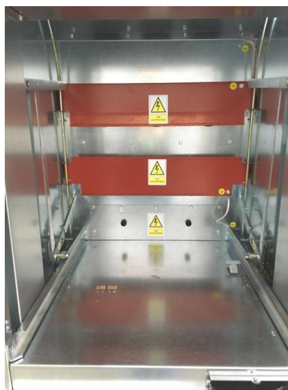
Рисунок 1.4 – Отсек выдвижного элемента при извлеченном КВЭ [3]
