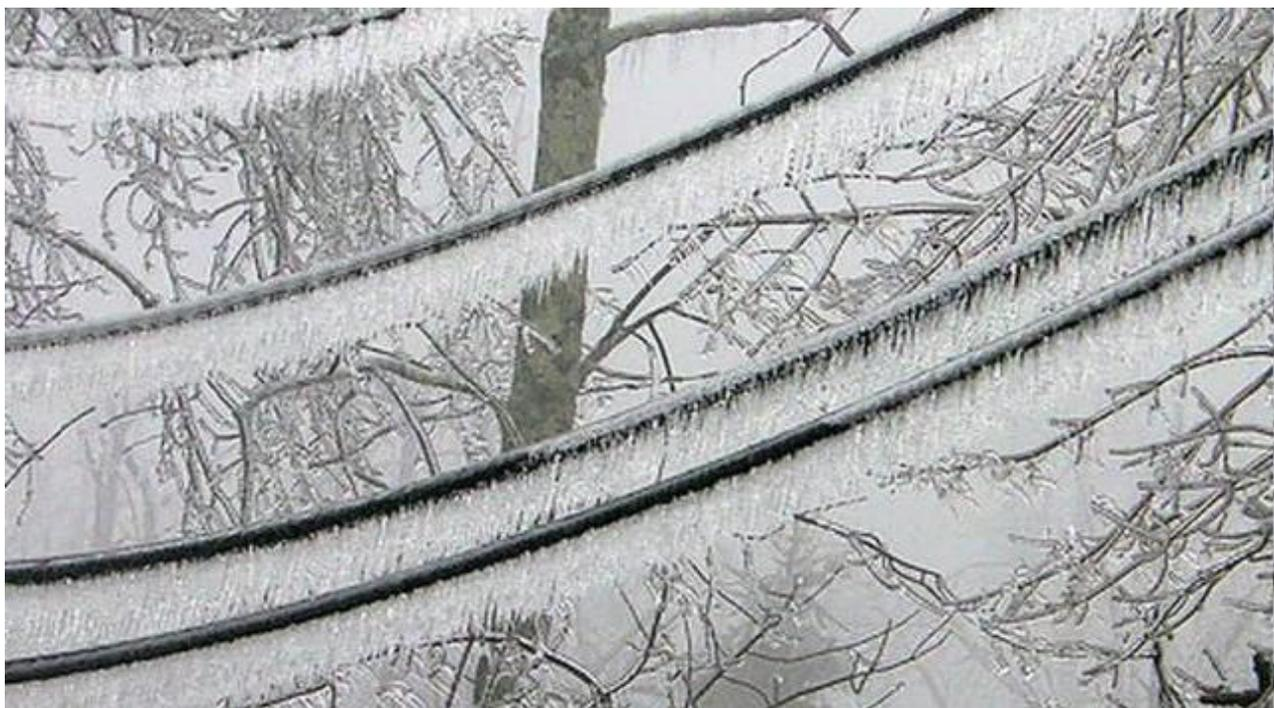
*Рис. 60. Последствия ледяного дождя – на проводах ЛЭП [65].*
