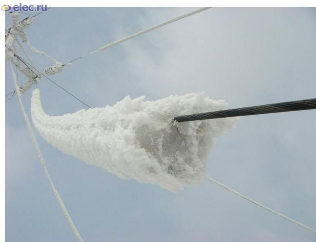
*Рис. 59. Гололед на проводах и опорах ЛЭП [64].*
