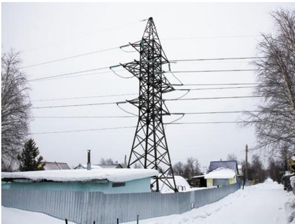
*Рис. 57. Нарушение требований [59] – землепользователь включил часть охранной зоны линии в свое подворье [62].*
