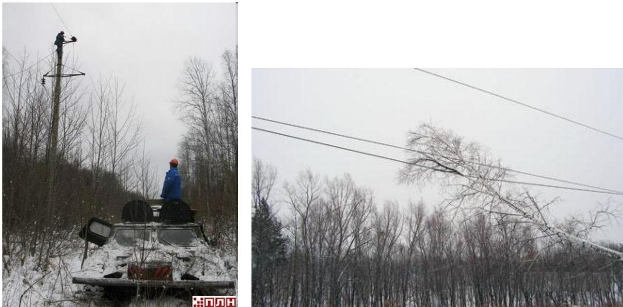
*Рис. 58. Последствия несвоевременной расчистки трассы ЛЭП от зарослей [63].*
