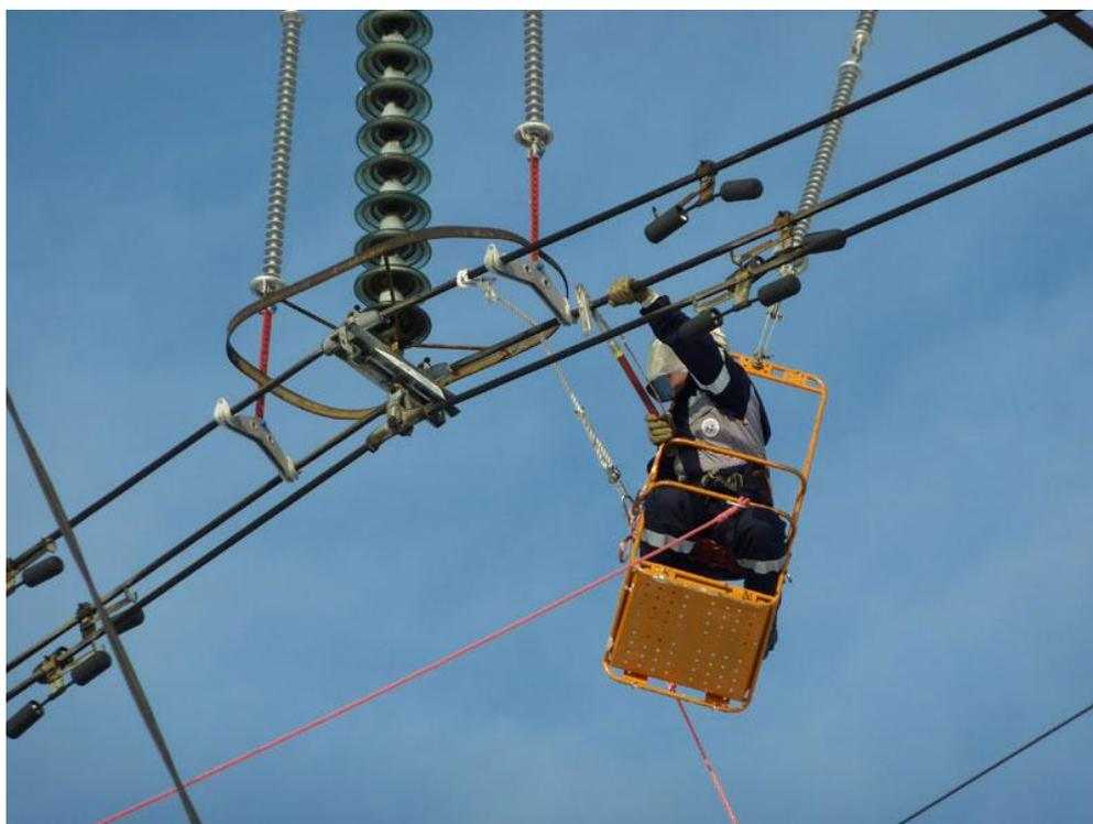
*Рис. 62. Работа на воздушной линии без снятия напряжения*
