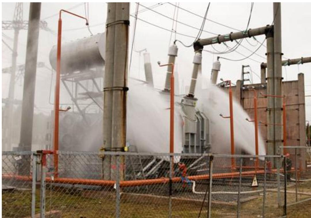
*Рис. 35. Стационарная система пожаротушения силового трансформатора [39].*
