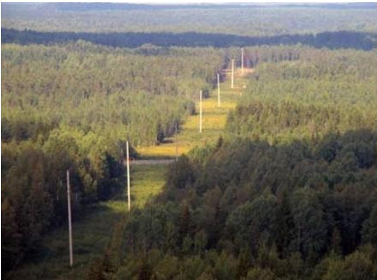
*Рис. 56. Просека для прокладки ВЛ в лесном массиве [61].*
