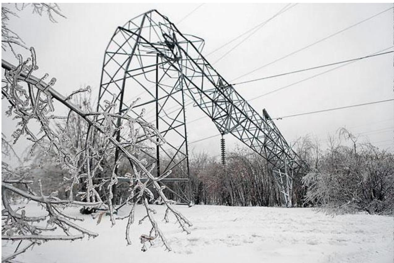
*Рис. 61. Опора ЛЭП не выдержала возросшую из-за ледяного дождя механическую нагрузку [66].*
