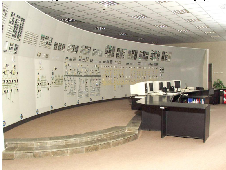
Рис. 57. Главный щит управления Московской ТЭЦ 27
