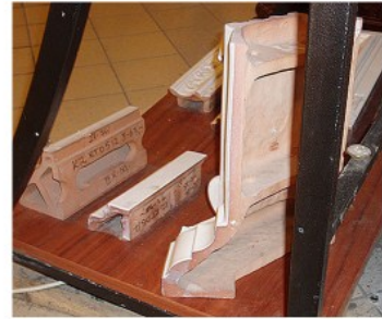
Все изразцовые элементы также имеют пустотелую конструкцию.
