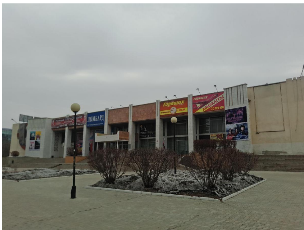
Рисунок А.2 - Фотофиксация объекта (южный фасад ДК Профсоюзов)
