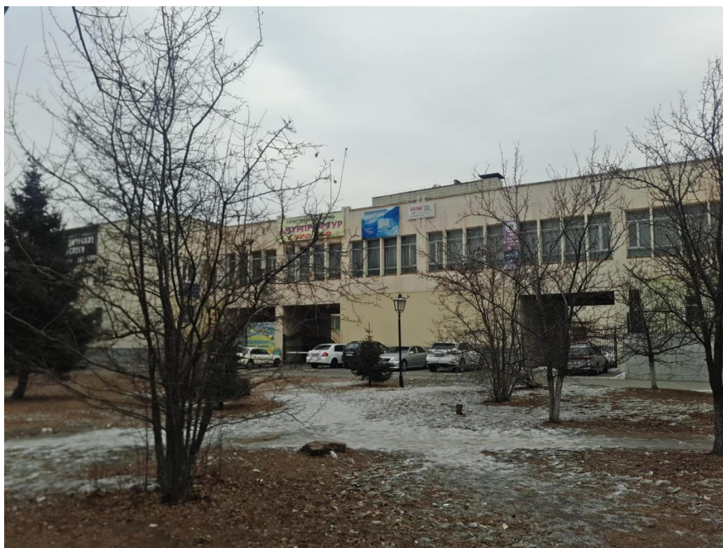
Рисунок А.4 - Фотофиксация объекта (западный фасад)
