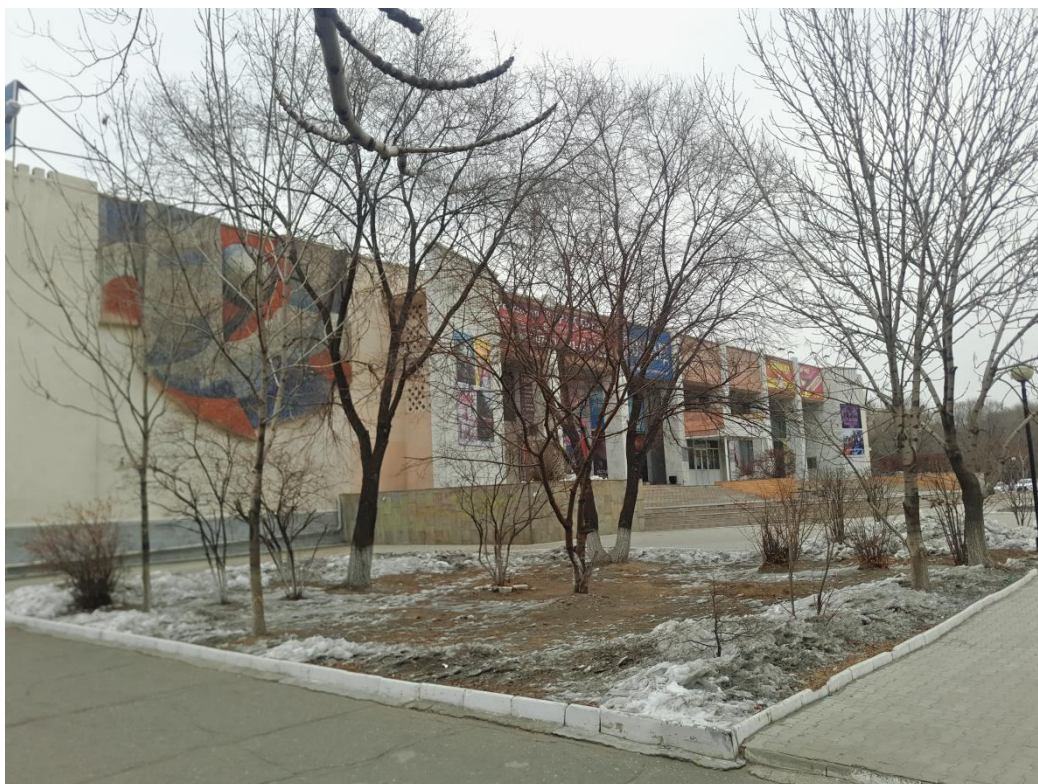
Рисунок А.3 - Фотофиксация объекта (южный фасад)
