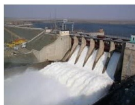
8. АВТОМАТИЧЕСКОЕ УПРАВЛЕНИЕ НА ГЭС
