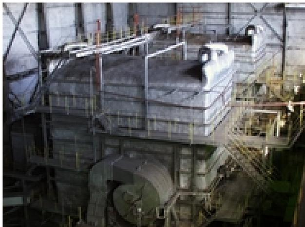
Рисунок 7- Водогрейные котлы №1,2 КВГМ-100, производительностью 100 Гкал/ч каждый.
