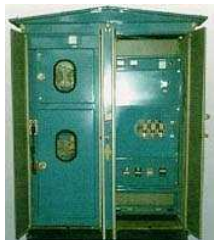
Подстанция комплектная трансформаторная тупиковая типа КТП-ТК
