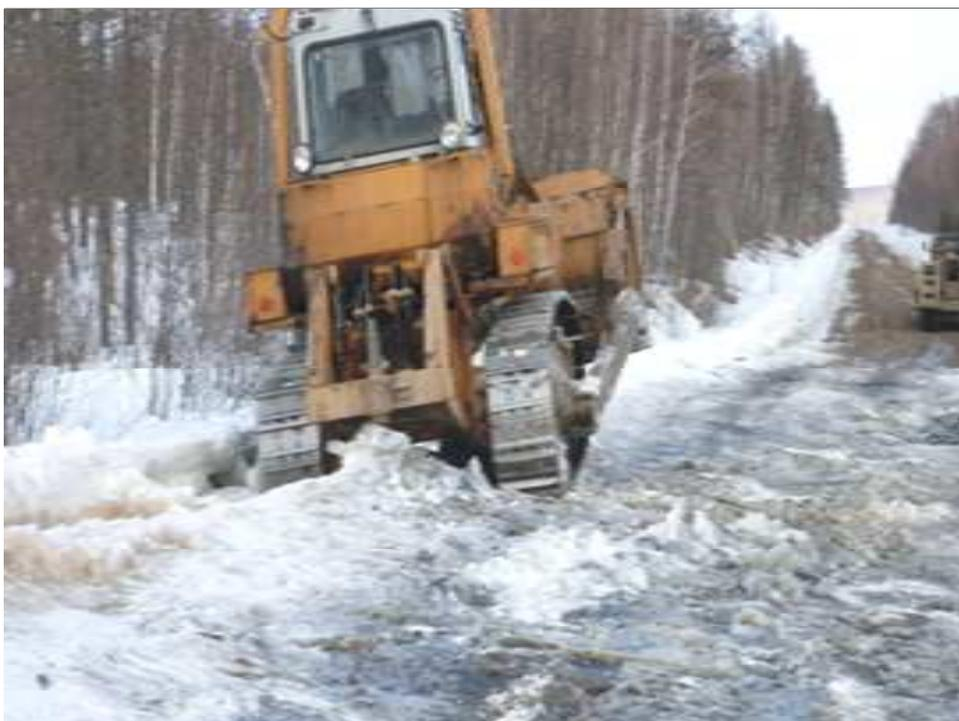
Рис. 2. Проведение противоналедных работ в районе 45 км автодороги Февральск – Стойба. На рисунке показано как с помощью дорожной спецтехники убирают наледь с проезжей части. С левой стороны дороги делают канаву для стока воды при таянии наледи в весенний период.
