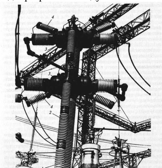
Рис. 4.41. Полюс воздушного выключателя ВВБК-220:
