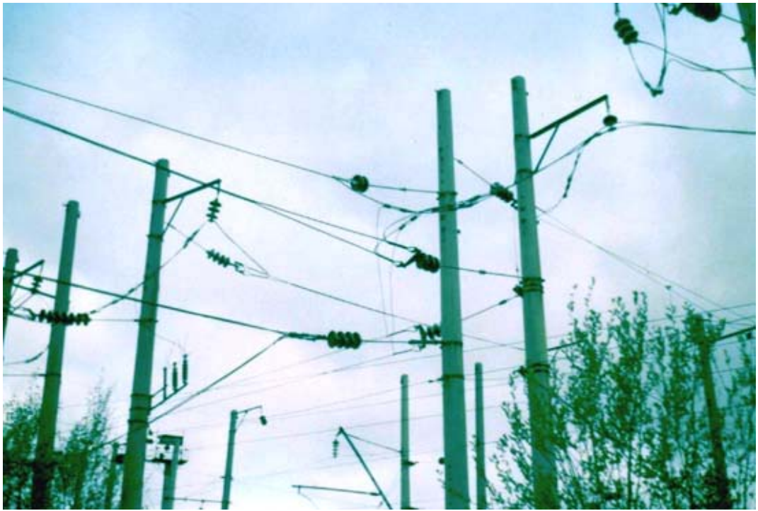
Рисунок 3 – Угловые опоры питающих линий.
