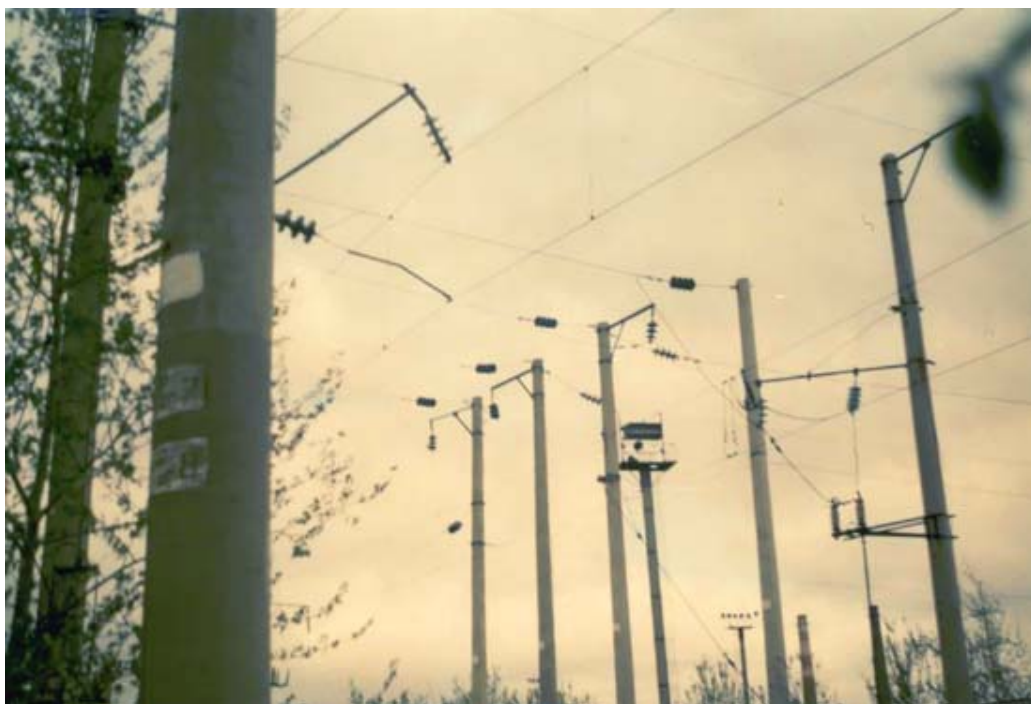
Рисунок 5 – Концевые опоры питающих линий.
