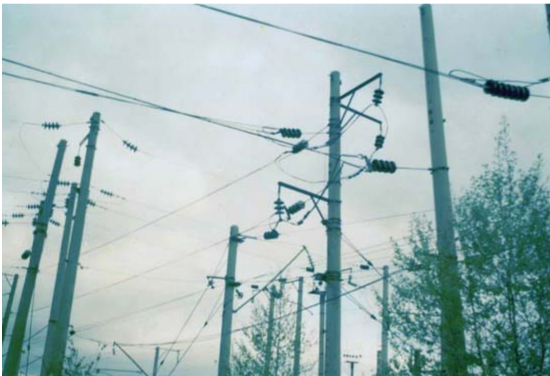
Рисунок 4 – Угловые опоры питающих линий (анкеровка).
