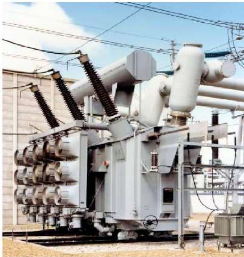
Рис. 3-12, б. Силовой трансформатор с принудительной циркуляцией масла и дутьевым охлаждением радиаторов.
