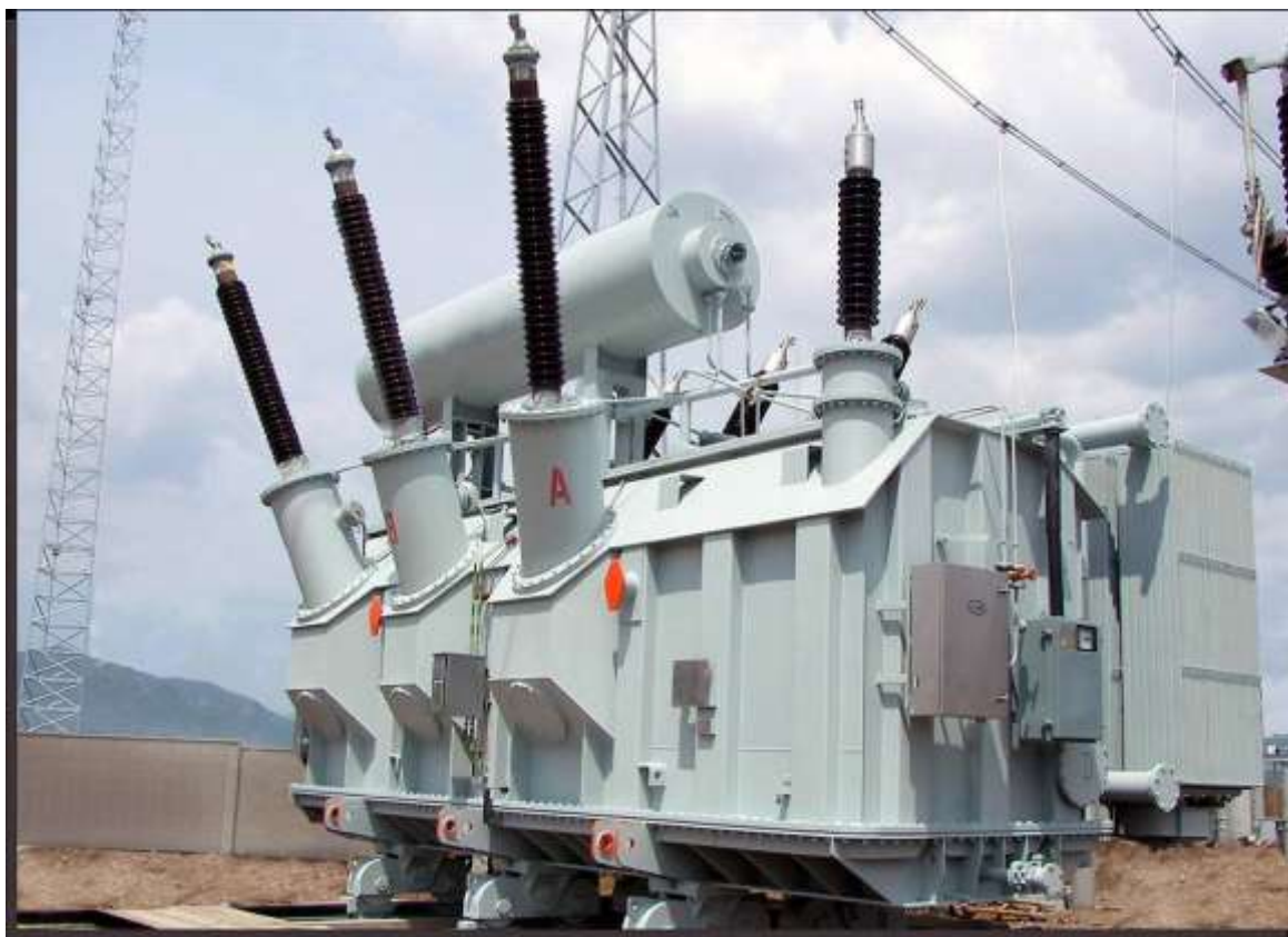
Рис. 3-10. Трансформатор с баком колокольного типа.
