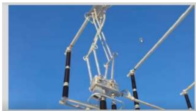
Рис. 5-9. Полюс разъединителя типа РПВ в отключенном включенном положении.
