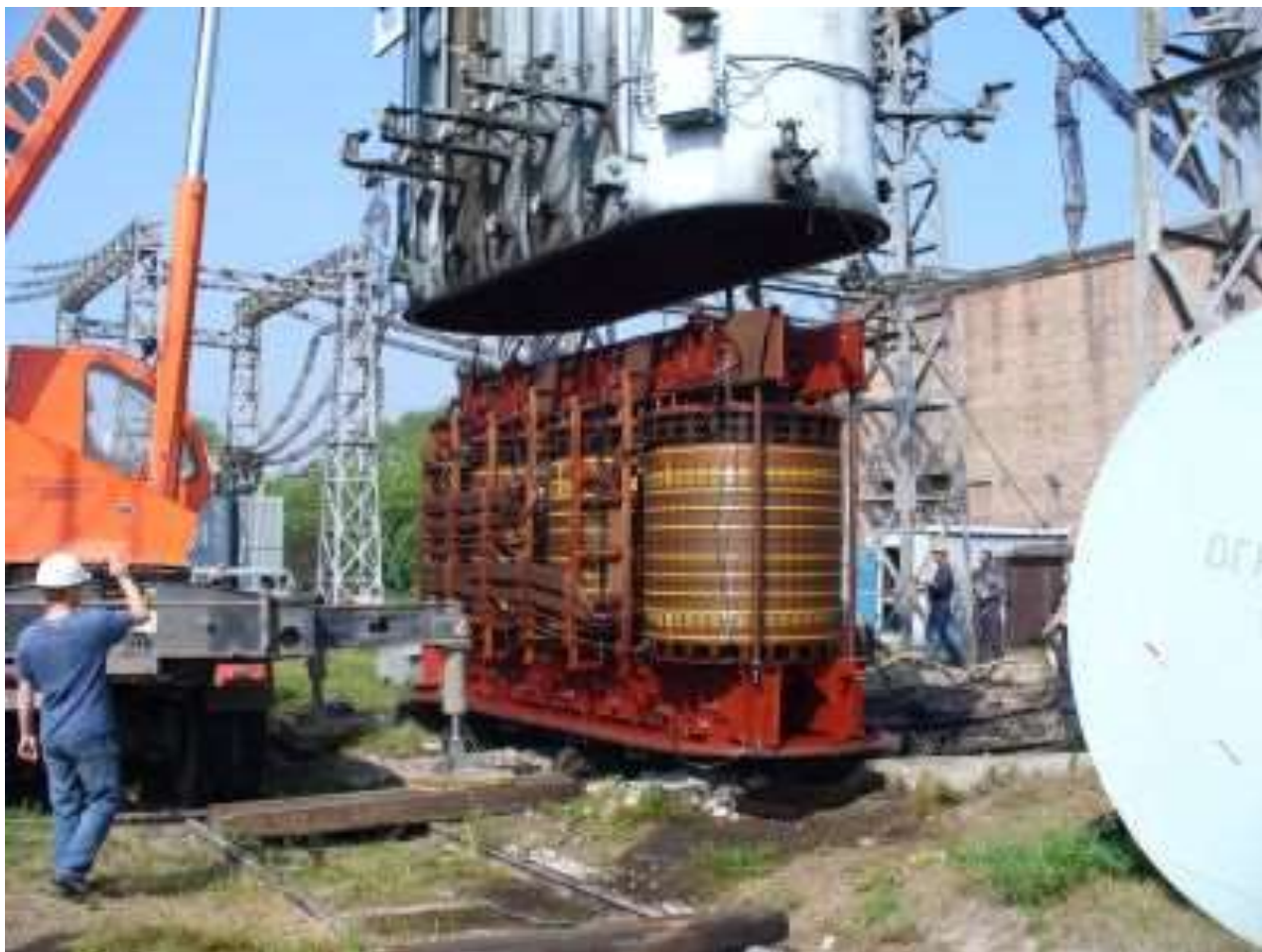
Рис. 3-11. Ремонт трансформатора с баком колокольного типа.
