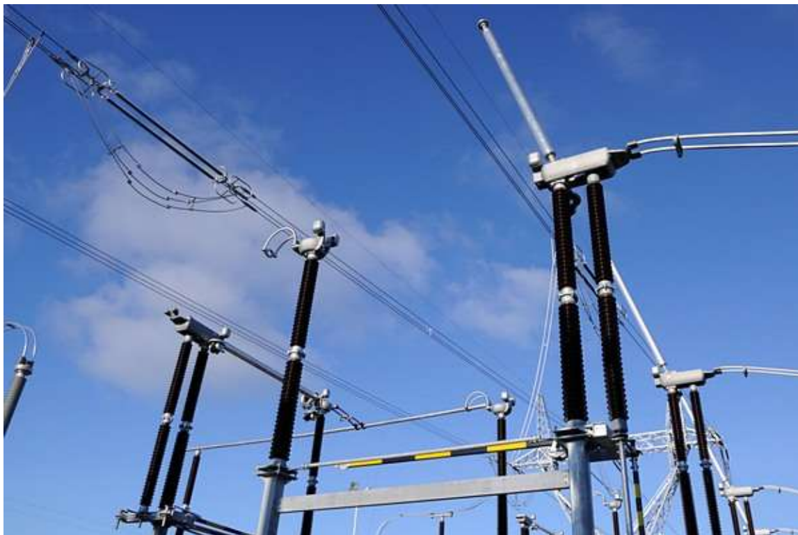
Рис. 5-5. Одна из возможных конструкций такого разъединителя. Производитель – фирма НАРАМ, тип – VSSBIII. Выпускается на напряжение 245 – 550 кВ.
