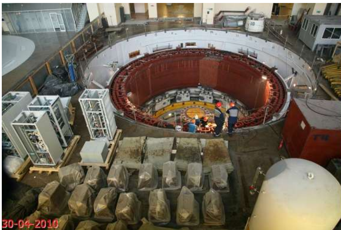
Рис. 2-12. Внешний вид статора гидрогенератора в процессе монтажа.
