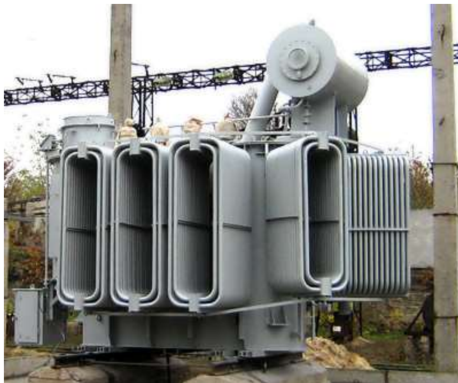
Рис. 3-8, в. Трансформатор с естественным масляным охлаждением. ТМ-6300/35.
