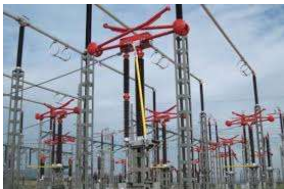
Рис. 5-9. Полюс разъединителя типа РПВ в отключенном включенном положении.
