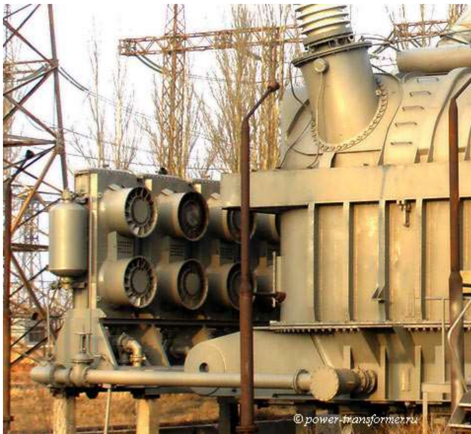
Рис. 3-12, г. Групповое охлаждающее устройство (ГОУ-3) [3-12].
