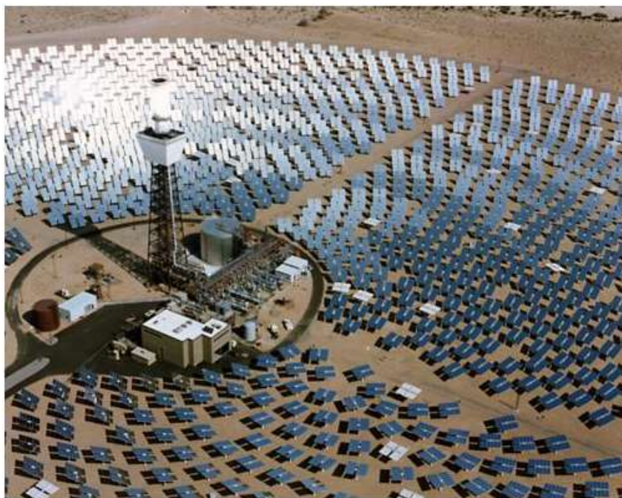
Рис. 1-8. Солнечная электростанция в Калифорнии, использующая концентрацию солнечного света системой зеркал [1-2].
