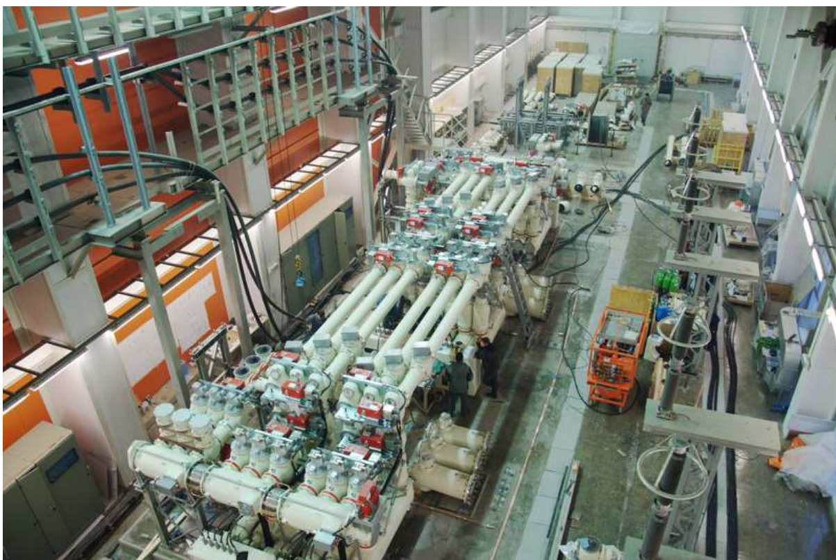
Рис. 6-6. Монтаж шинных конструкций, вид сверху. Слева на снимке – кабельная эстакада и кабели, подходящие к КРУЭ от повышающих трансформаторов. Справа – ОПН 220 кВ
