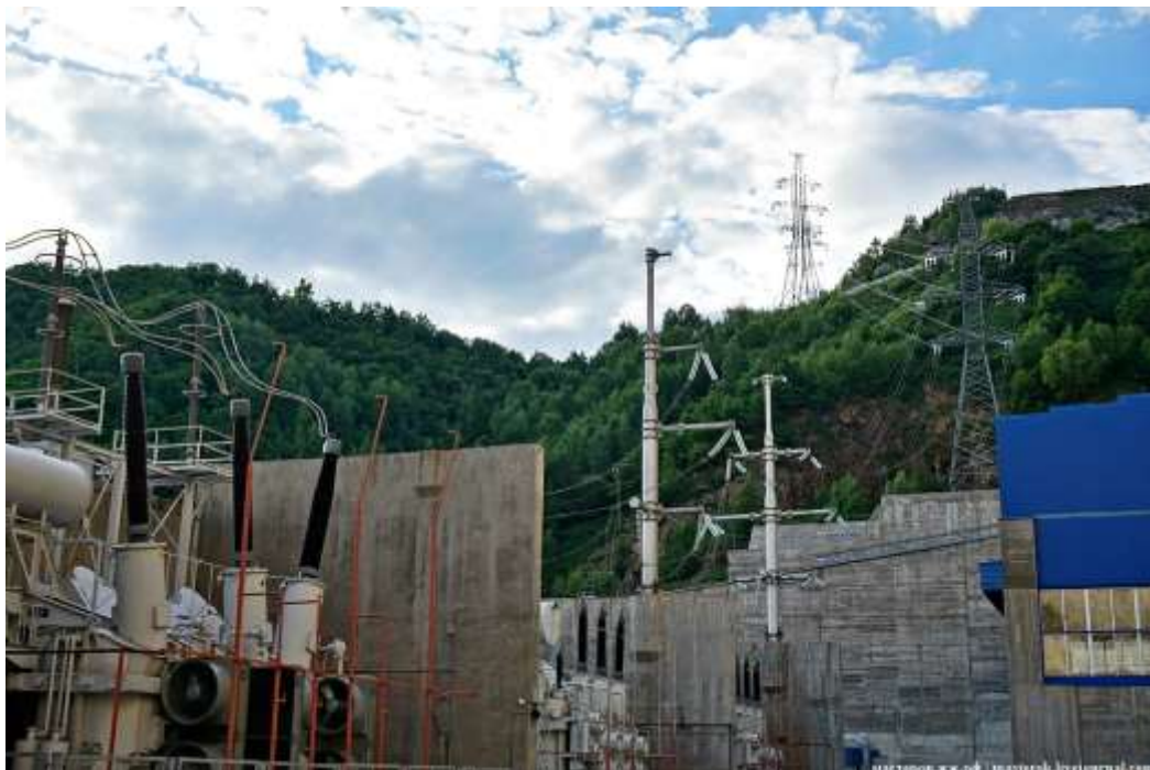
Рис. 8-7. Воздушные линии 220 кВ от повышающих трансформаторов первого и второго блока к открытому распределительному устройству 220 кВ.
