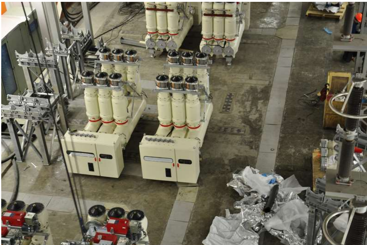
Рис. 6-5. Расстановка выключателей в здании КРУЭ (монтаж первой очереди КРУЭ).
