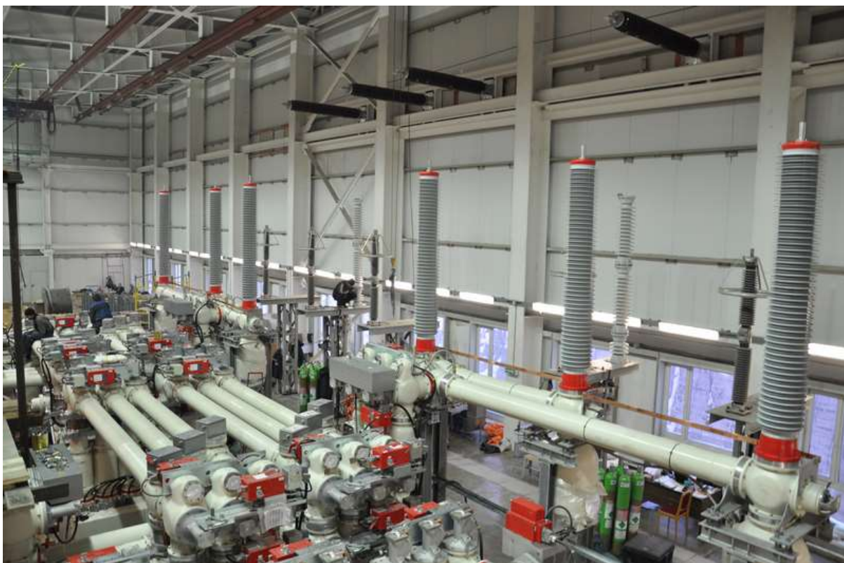
Рис. 6-7. Монтаж токоведущих элементов линий. В верхней части снимка – проходные изоляторы фаз ЛЭП.
