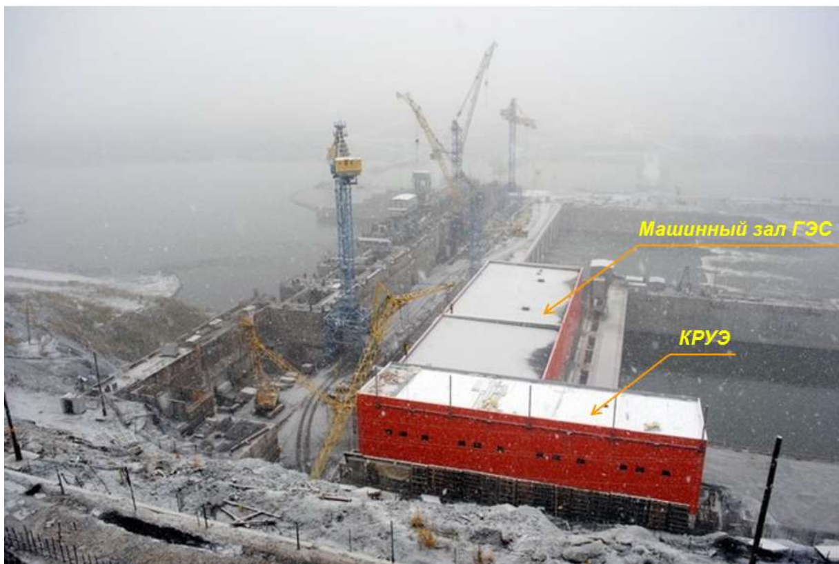
Рис. 6-1. На переднем плане – здание КРУЭ 220 кВ Усть-Среднеканской ГЭС.
