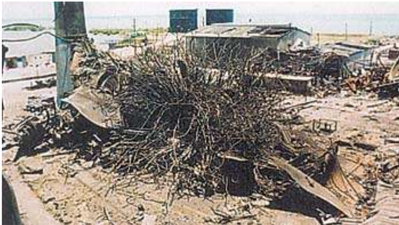
Рис. 3-10. Полное разрушение котельной установки из-за взрыва в топке.
