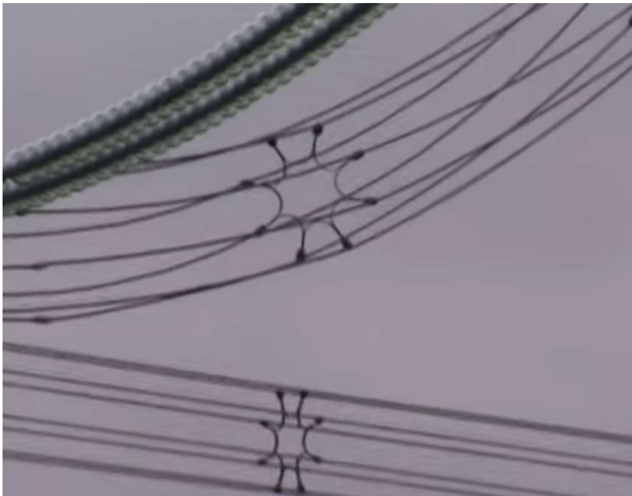
Рис. 7-3. Конструкция фазы 1150 кВ.
