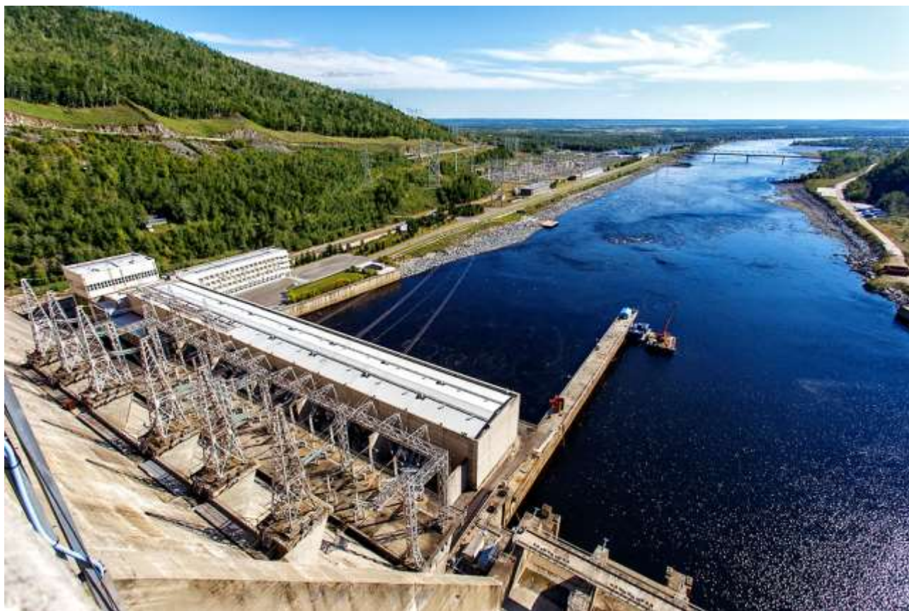
Рис. 8.3. Зейская ГЭС. Справа в нижней части снимка – бассейн водосброса, слева – здание ГЭС, а в пазухе между ним и плотиной – повышающие трансформаторы и порталы перемычек 220 и 500 кВ; в верхней части снимка, вдаль на левом берегу – территория открытых распределительных устройств 220 и 500 кВ [8-3].
