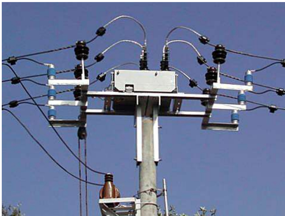
Рис. 5-2. Реклоузер РВА/TEL «Таврида Электрик».
