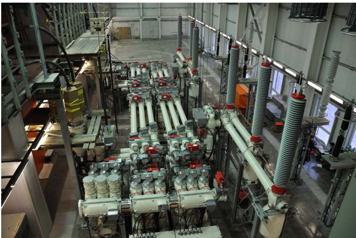
Рис. 6-8. Монтаж КРУЭ-220 первой очереди почти завершен, впереди – испытания. Свободная площадка на дальнем плане – для второй очереди КРУЭ..
