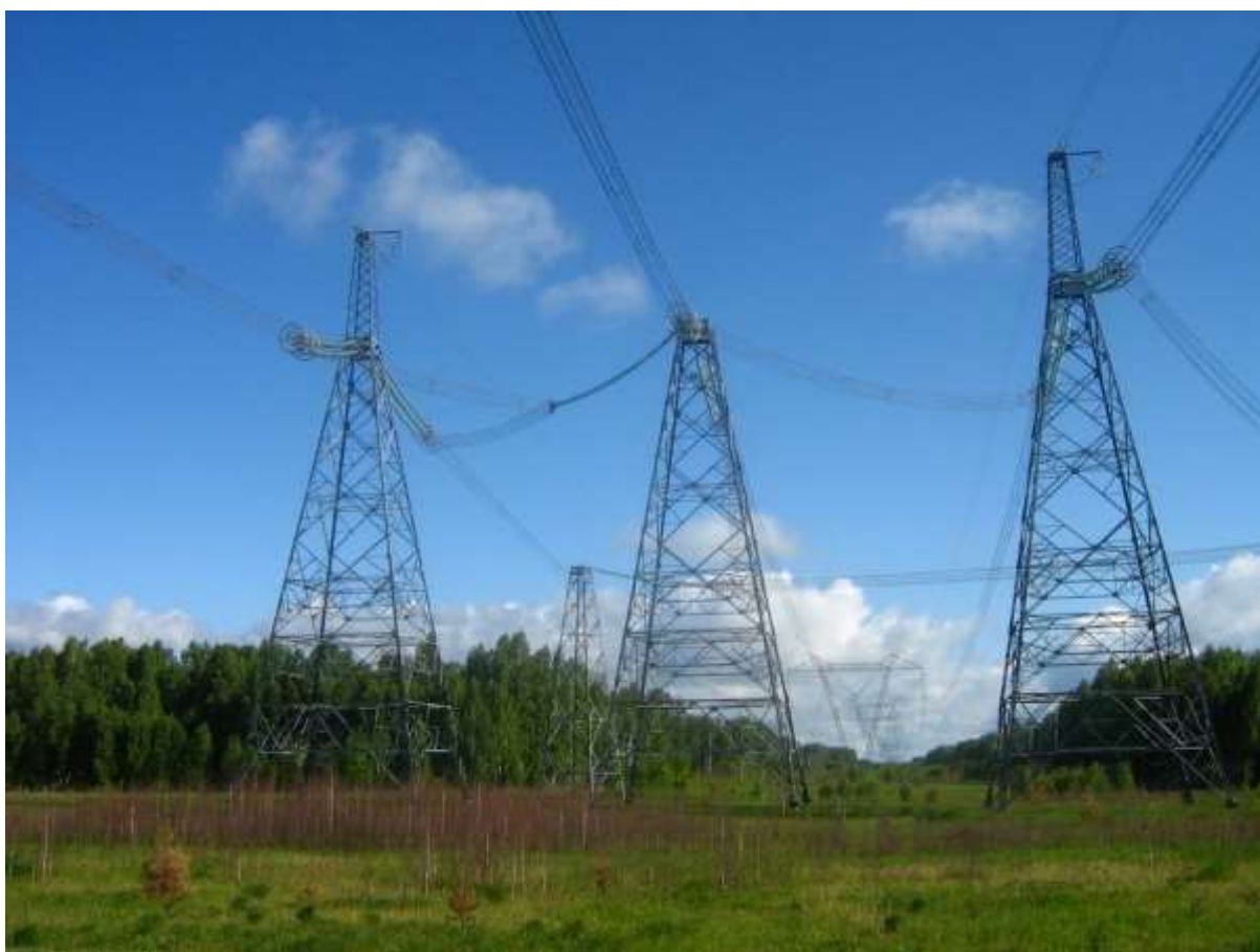
Рис. 7-2. Анкерные опоры ВЛ 1150 кВ.
