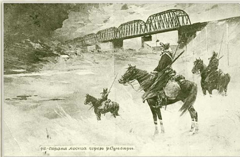
Охрана моста через р. Сунгари.
