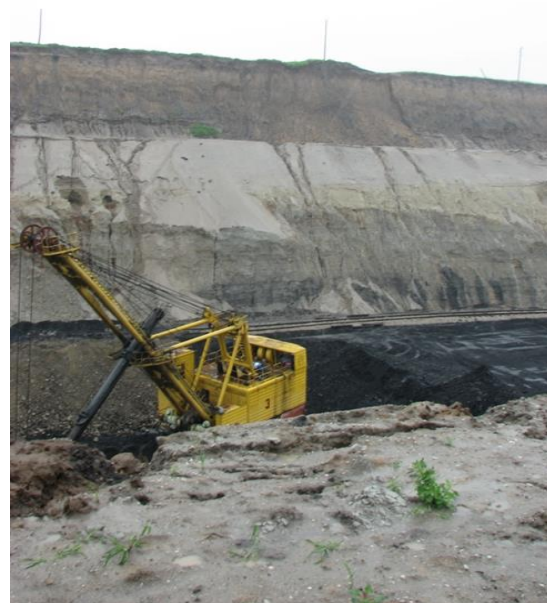
Рис. 41. Выемка угля малым гусеничным экскаватором.
