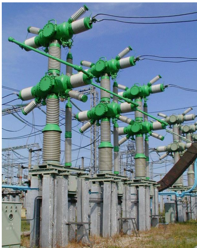
Рисунок 12 – Воздушный выключатель ВВБК-220 кВ.
