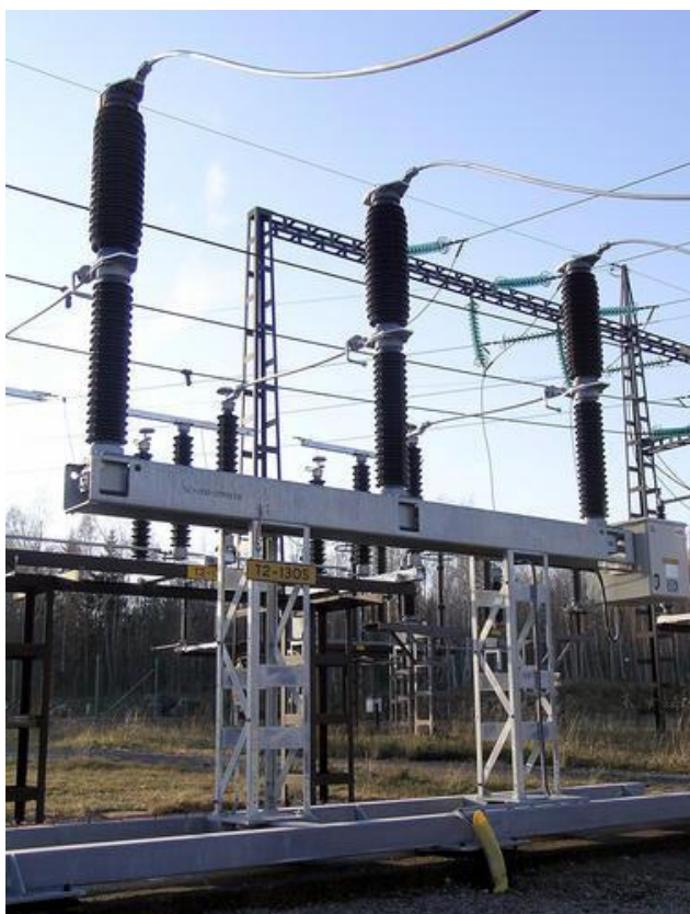
Рисунок 18 – Выключатель элегазовый колонковый LTV 145D1/B
