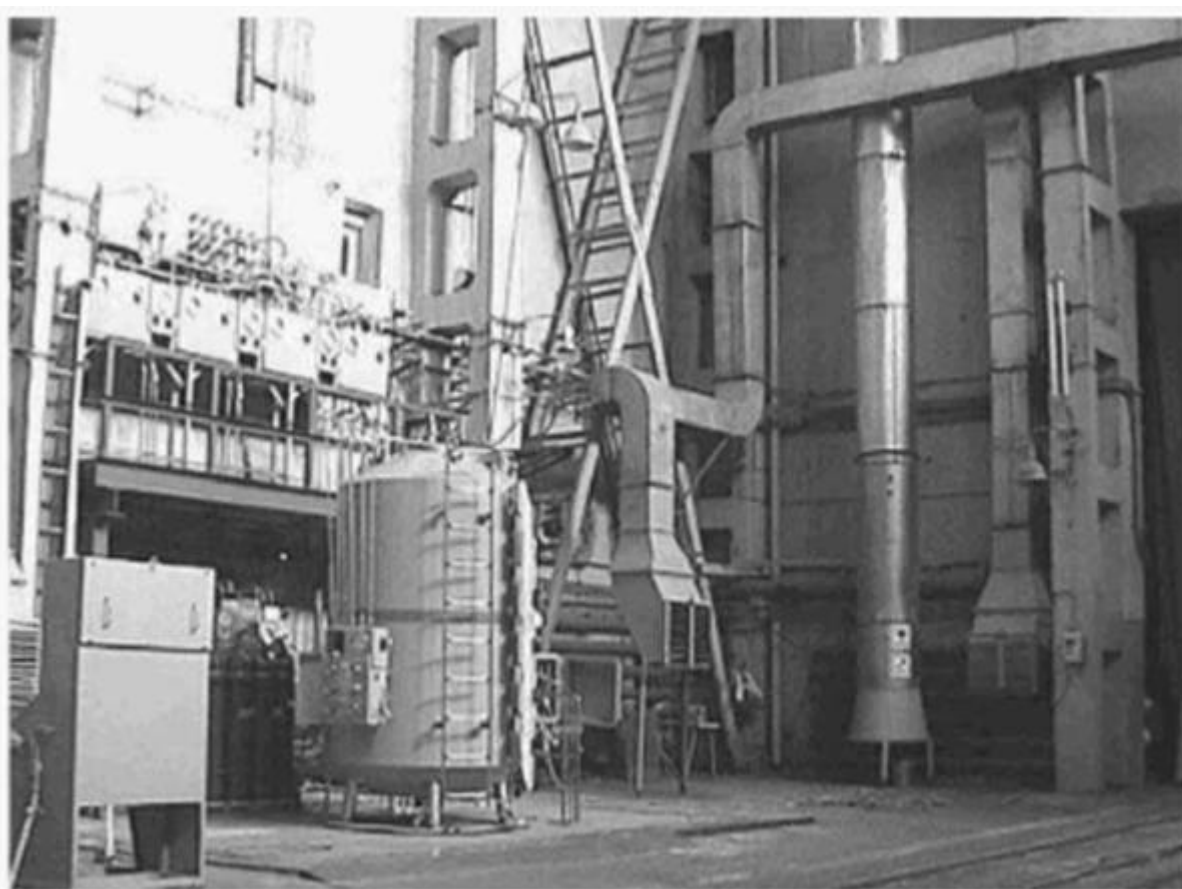
Рисунок 8 — Емкость дозатора, установленная на платформе весового устройства
