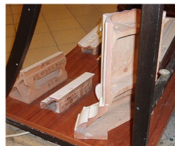
Все изразцовые элементы также имеют пустотелую конструкцию.
