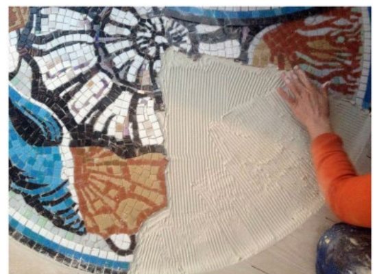
4. Панно по частям (или целиком) переносится место и приклеивается
