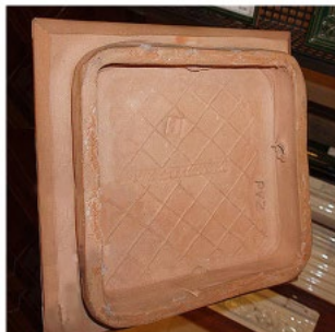
Конструкция изразца. Румля с отверстиями на тыльной стороне.
