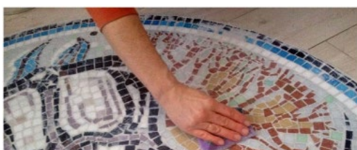
Обратный способ укладки мозаики
