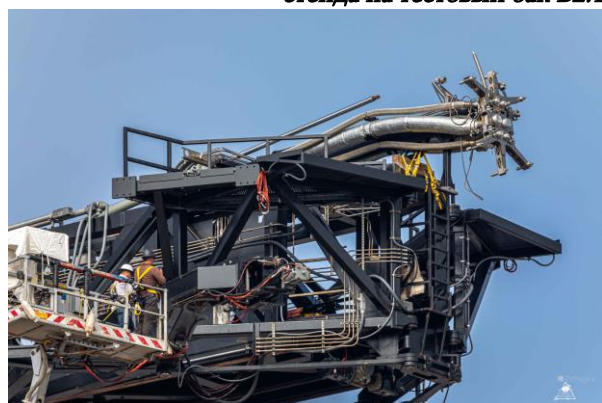
Фото 4. Работы с "заправочным рукавом" для корабля
