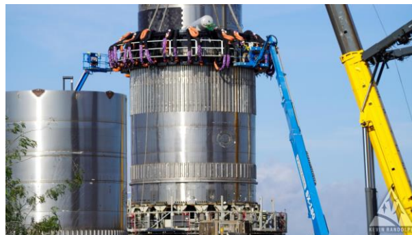
Фото 2. Установка новой части испытательного стенда на тестовый бак B2.1
