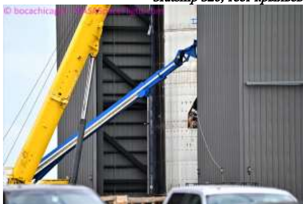
Установка обтекательных элементов
