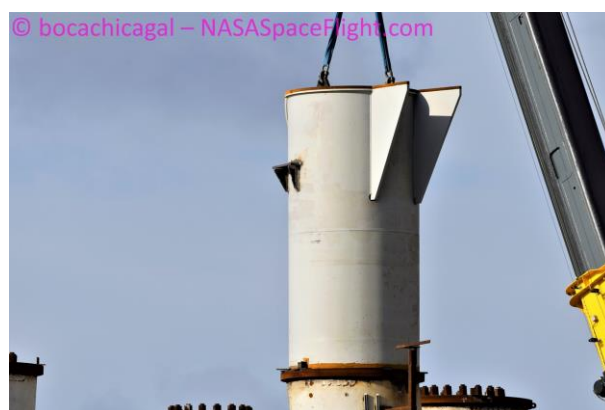
Новая часть опор
