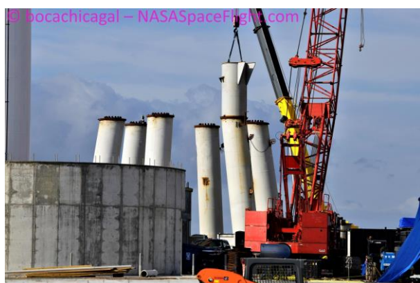
Строительство стартового стола
